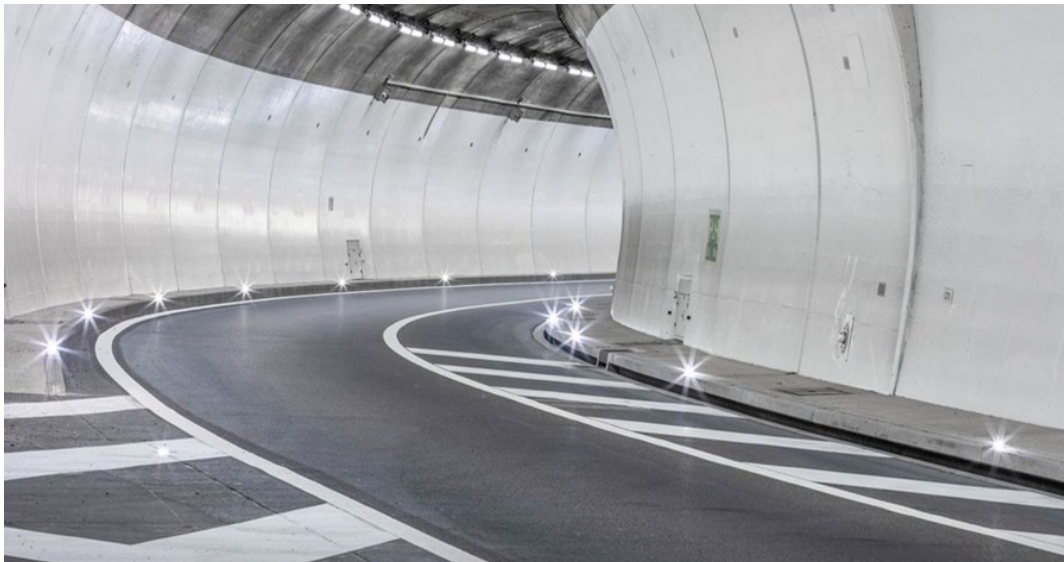
Abb. 16 Helle Wände, optische Leiteinrichtungen auf dem Bankett, gute Beleuchtung (Bild: Gifas, 18.12.2019, https://www.gifas.ch ).
