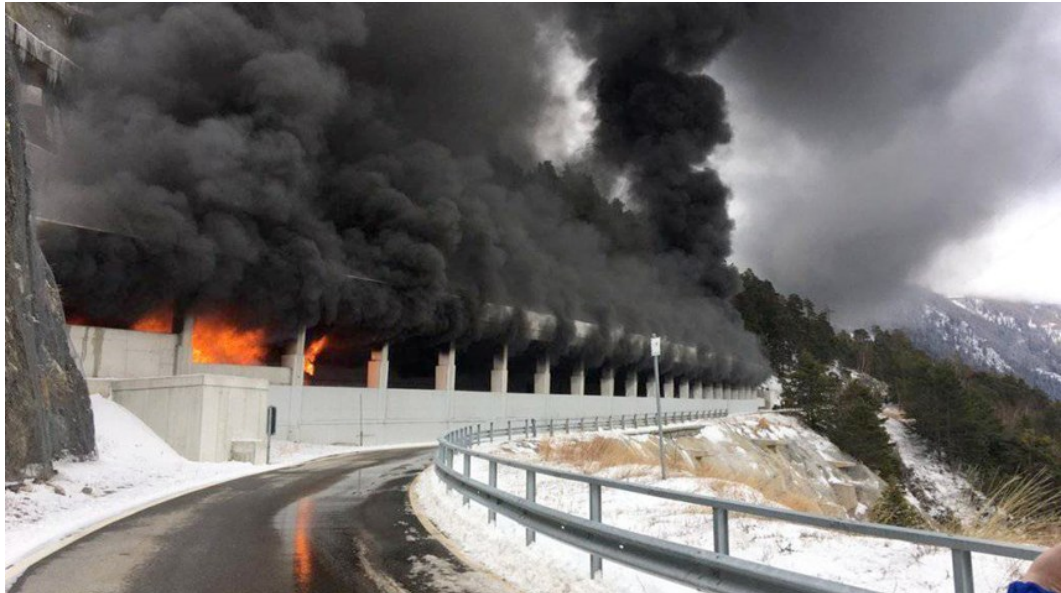
Abb. 4 Brand Schallbergtunnel und -galerie (Simplonpassstrasse) (Bild: TicinoNews, 2019, https://www.ticinonews.ch ).
