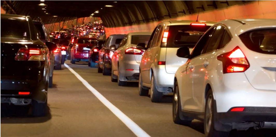
Abb. 6 Stau im Tunnel ohne Rettungsgasse – kein Durchkommen für die Einsatzkräfte (Bild: Dreamstime, https://www.dreamstime.com ).
