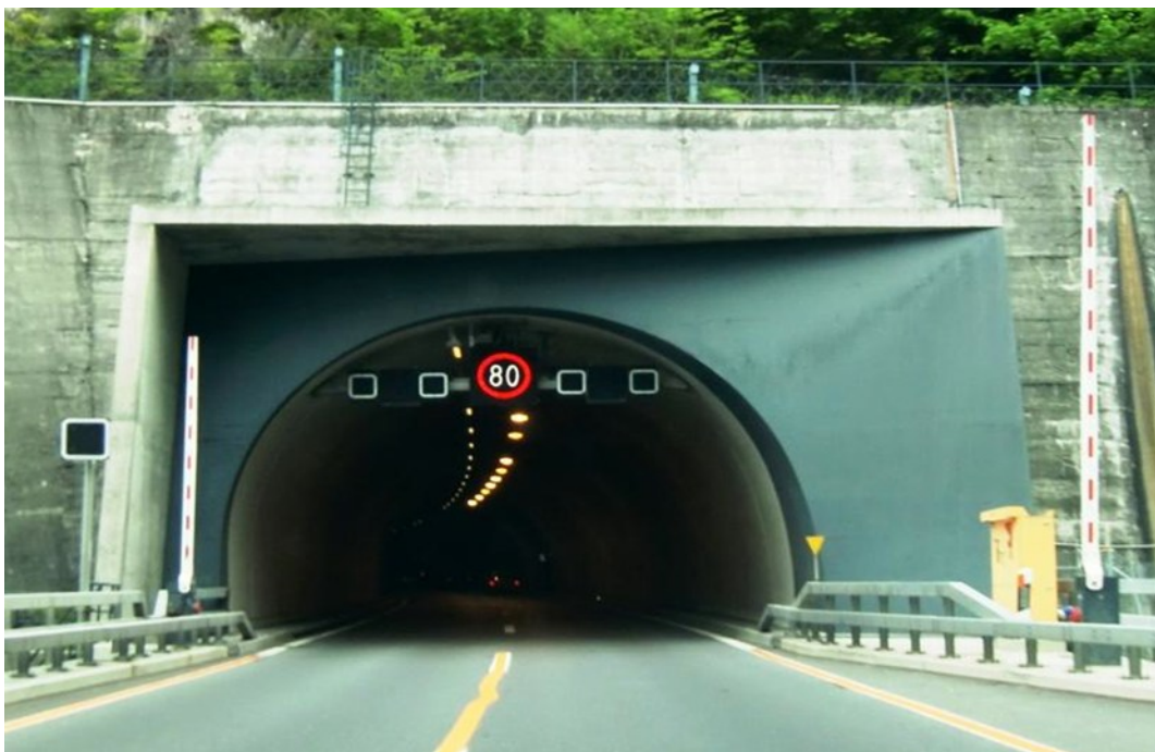
Abb. 12 Barriere beim Tunnel Glion.
