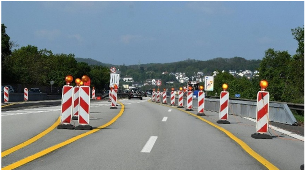
Abb. 14 Fahrspurüberleitung bei einer Autobahnbaustelle (Bild: t-online, 20.07.2019, www.t-online.de ).
