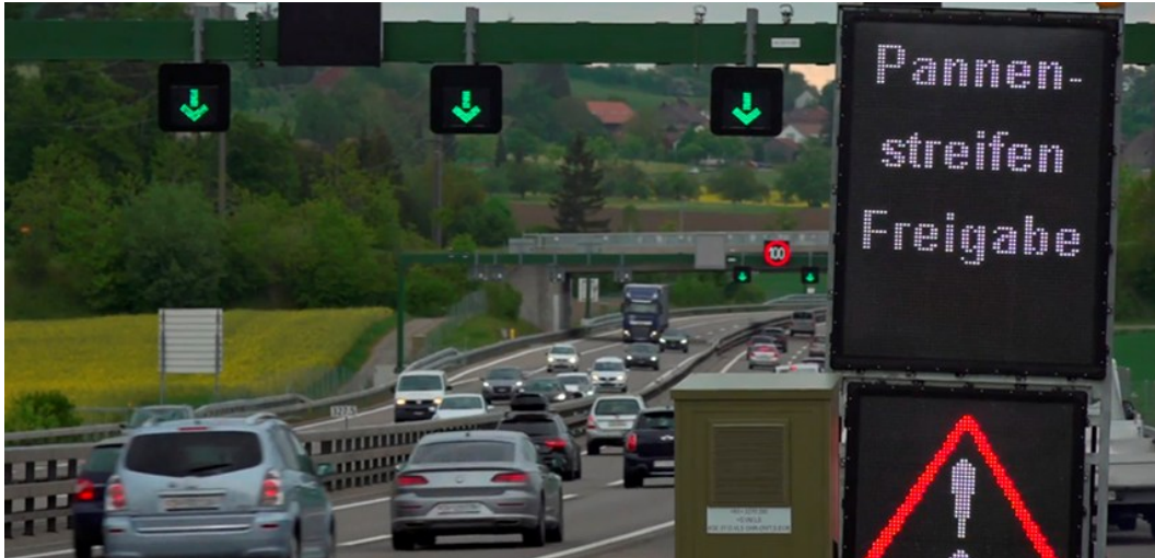
Abb. 9 Temporäre Pannestreifenumnutzung bei Spitzenverkehr.
