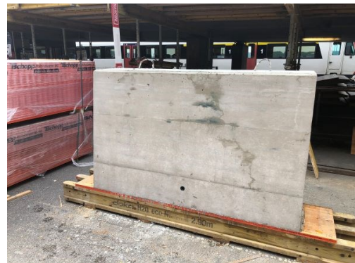
Abb. 5.4 Ausgeschaltes Musters auf der Baustelle: a) Hinterseite, b) geneigte Vorderseite. Fotos J.-M. Zweiacker.
