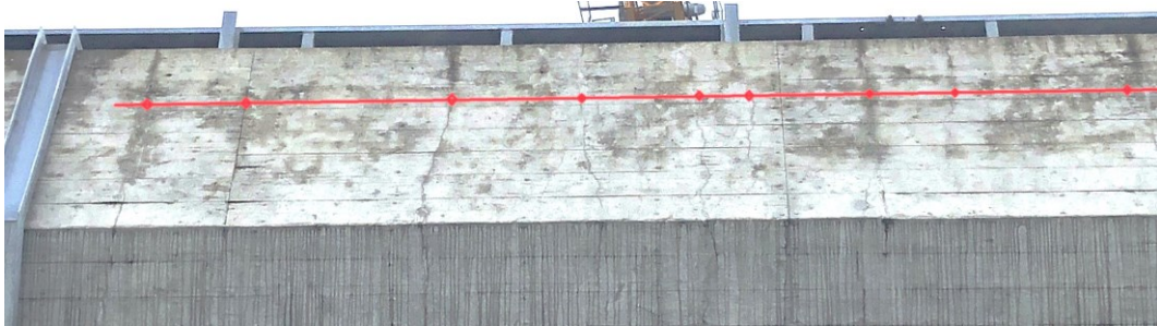
Abb. 2.8 Ungünstige Rissverteilung bei einer Brüstung, mehrheitlich eine Folge der Überfestigkeiten des Betons. Grobe Risse sind rot markiert. Foto M. Käser.
