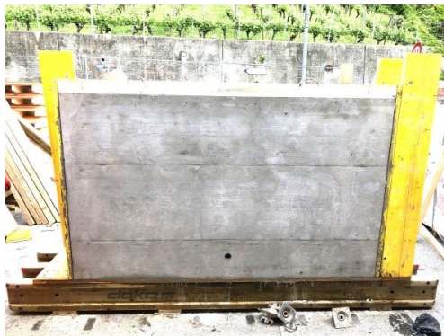
Abb. 5.4 Ausgeschaltes Musters auf der Baustelle: a) Hinterseite, b) geneigte Vorderseite. Fotos J.-M. Zweiacker.
