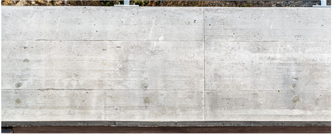
Abb. 6.16 a) Aussenseite der Brüstung auf der Seeseite: a) Sehr feine vertikale Risse bis Oberkante; b) Sehr feine netzartige Risse im mittleren Bereich. Fotos ASTRA vom 28.03.2022.
