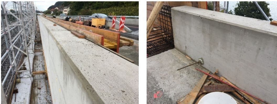
Abb. 6.1 Erscheinung der Betonoberfläche der südseitigen Brüstung nach dem Ausschalen. Fotos F. Hunkeler vom 04.10.2021.
