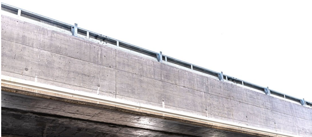
Abb. 6.13 Aussenseite der Brüstung auf der Bergseite mit Rissen und Ausblühungen. Foto ASTRA vom 28.03.2022.
