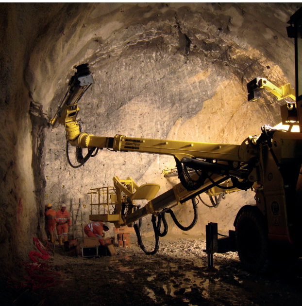
Die neue Röhre wird im Sprengvortrieb erstellt.
