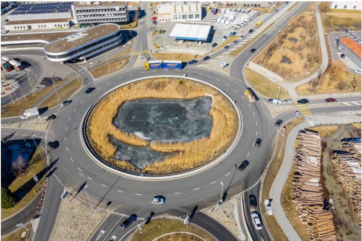
Bild 3: Strassenabwasserbehandlungsanlage im Bildackerkreisel in Brig VS
