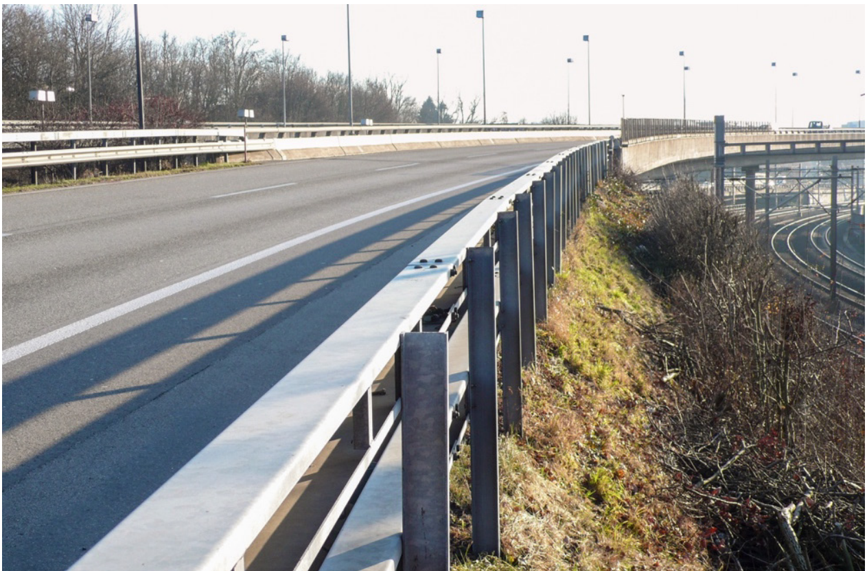
Bild 2: Fahrzeugrückhaltesysteme entlang der Stadttangente Bern
