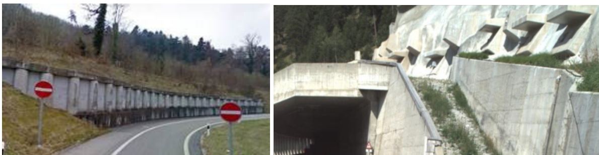
Abbildung 3.16 Beispiele für eine Pfahlwand (links) und eine Ankerwand (rechts)
