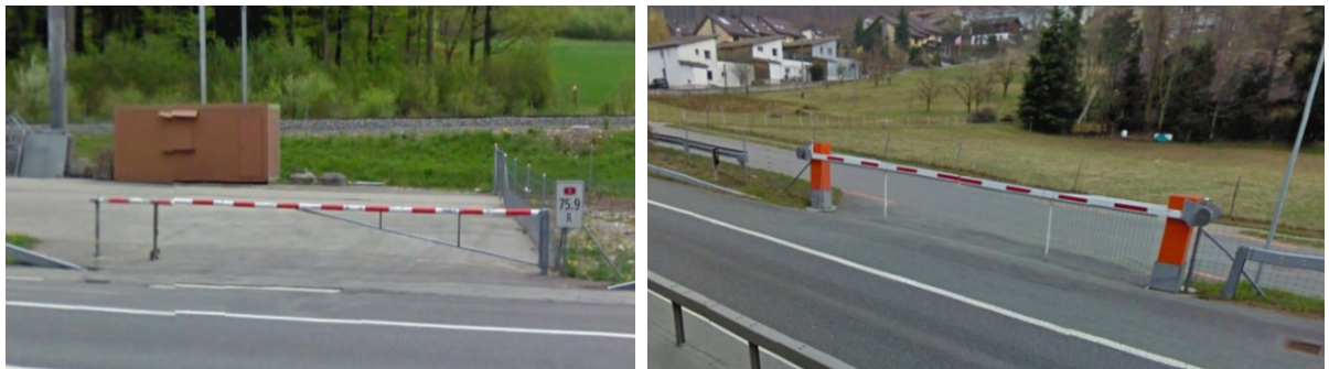
Abbildung 3.24 Beispiele für mechanische (links) und elektromechanische (rechts) Barrieren
