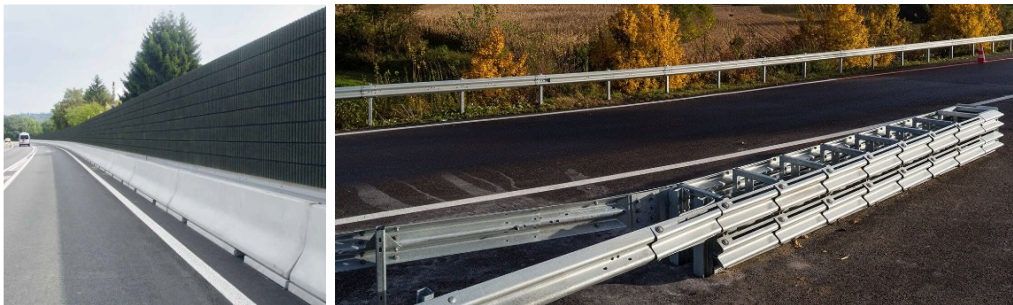
Abbildung 3.9 Beispiele für Lärmschutzwände mit DELTA BLOC® (links) und Anpralldämpfer (rechts)
