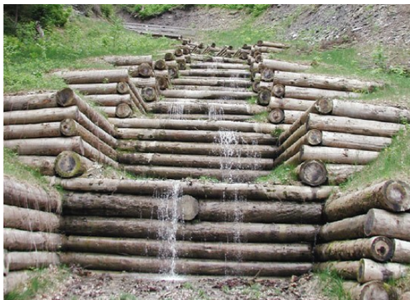
Abbildung 3.17 Beispiele für Bachsperrn aus Holz (links) und einen Kies- und Geschiebesammler (rechts), Quelle: Magazin "umwelt" 2/2012, Bundesamt für Umwelt BAFU
