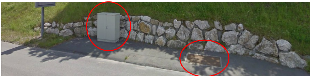
Abbildung 3.7 Beispiel für eine Elektroschrank (links, rot) und einen Elektroschacht (rechts, rot)
