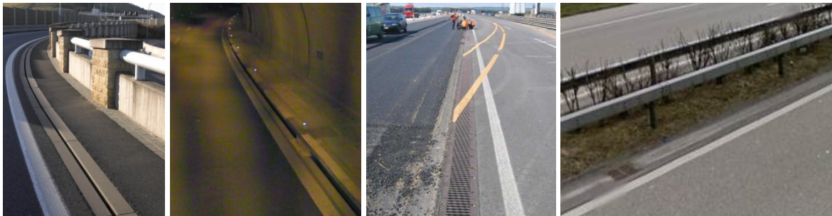
Abbildung 3.5 Beispiele für eine Schlitzrinne (links und Mitte links), eine Entwässerungsrinne (Mitte rechts) und eine Belagsrinne (rechts)
