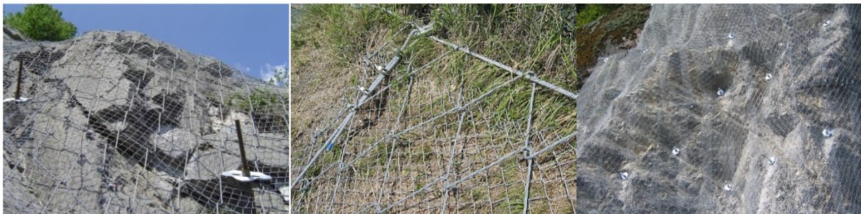
Abbildung 3.19 Beispiel für Steinschlagnetze an Felswänden, Quelle: Geobrugg AG, Romanshorn
