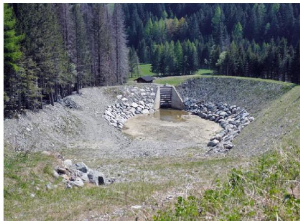
Abbildung 3.17 Beispiele für Bachsperrn aus Holz (links) und einen Kies- und Geschiebesammler (rechts), Quelle: Magazin "umwelt" 2/2012, Bundesamt für Umwelt BAFU
