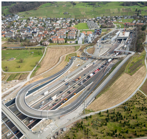
Die neue Auffahrtsrampe Weiningen, im Hintergrund ist die alte Rampe zu sehen.
