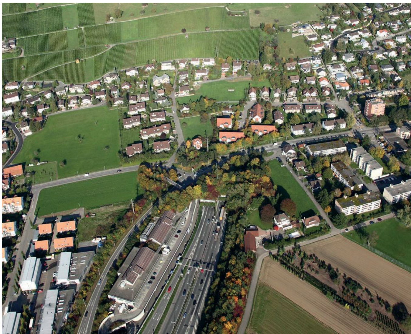
Portal des Gubristtunnels bei Weinigen, Copyright ASTRA
