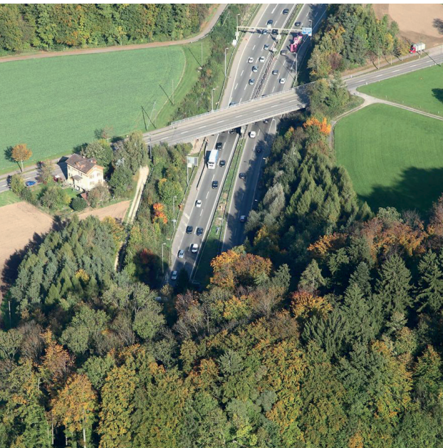
Portal des Gubristtunnels bei Zürich-Affoltern, Copyright ASTRA
