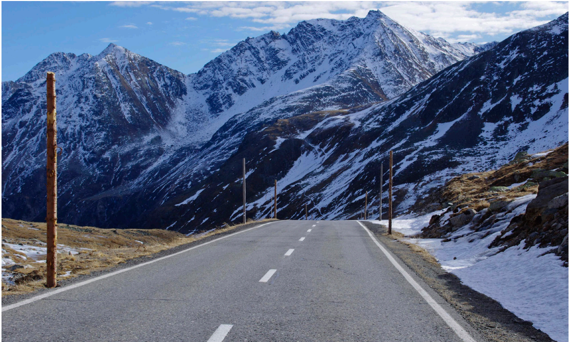
Abb. 50: Schlecht erkennbarer Strassenverlauf hinter der Kuppe.
