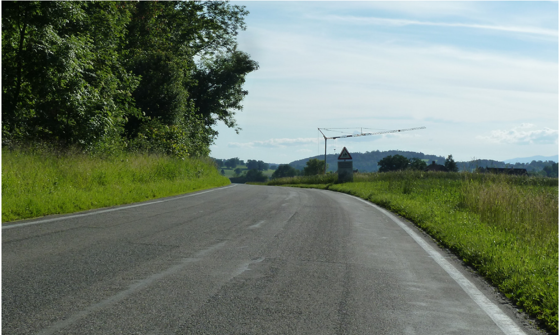
Abb. 52: Beispiel einer Kurve negativer Querneigung (Neigung „gegen aussen“)
