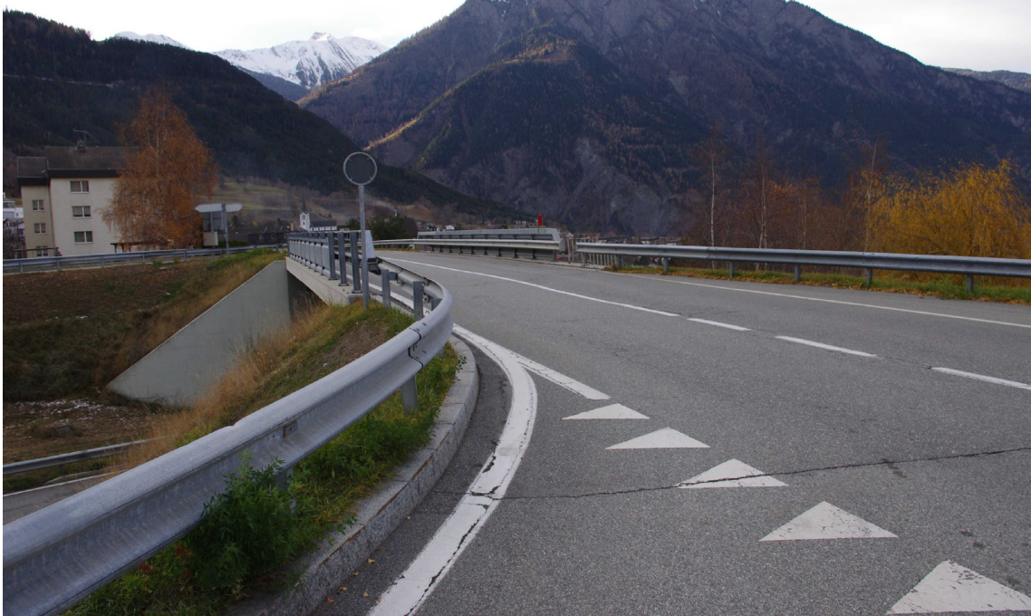
Abb. 34: Sichtbeeinträchtigung durch Fahrzeugrückhaltesystem
