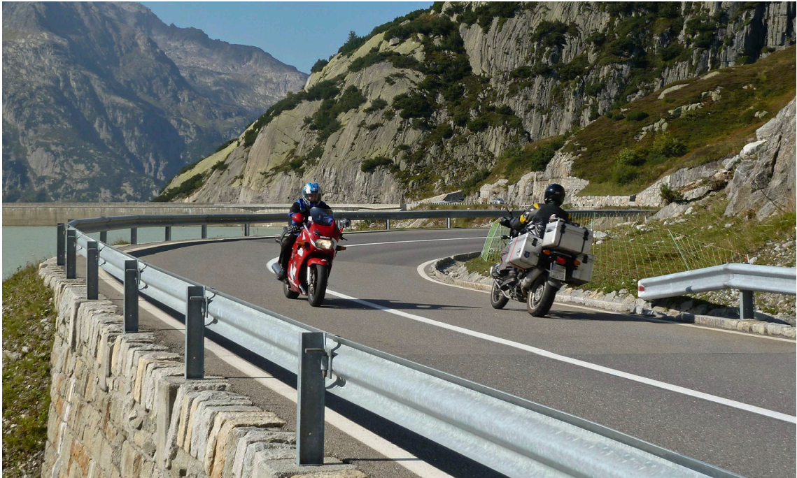
Abb. 85: Fahrzeugrückhaltesystem mit Pfosten (IPE) und Leitprofil
