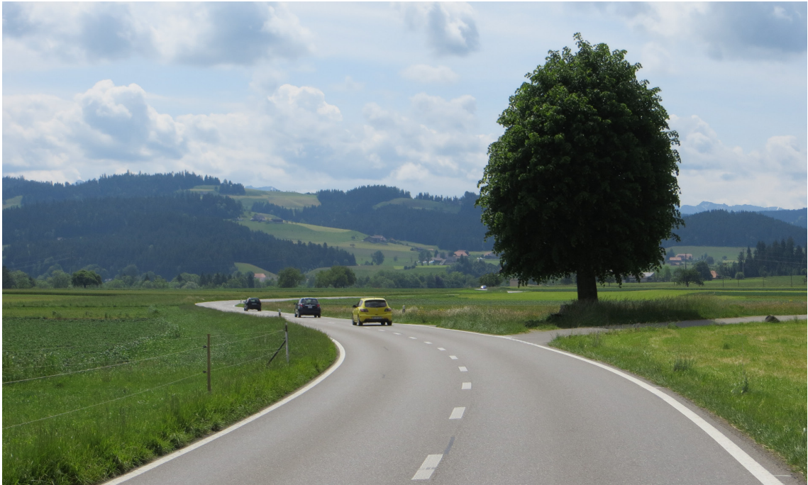
Abb. 79: Einzelbaum in potentiellem Sturzraum (Kurvenaussenseite) eines Motorrades
