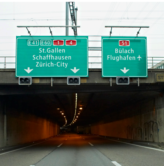
Portal des Stelzentunnels
