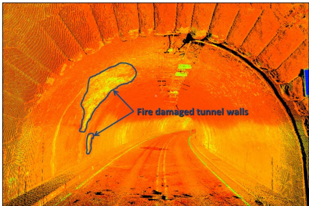
Abb. 8.123 Räumliche (intensitätsschattierte) Punktwolke im Portalbereich eines Tunnels, aufgenommen mittels Laserscanner [272].
