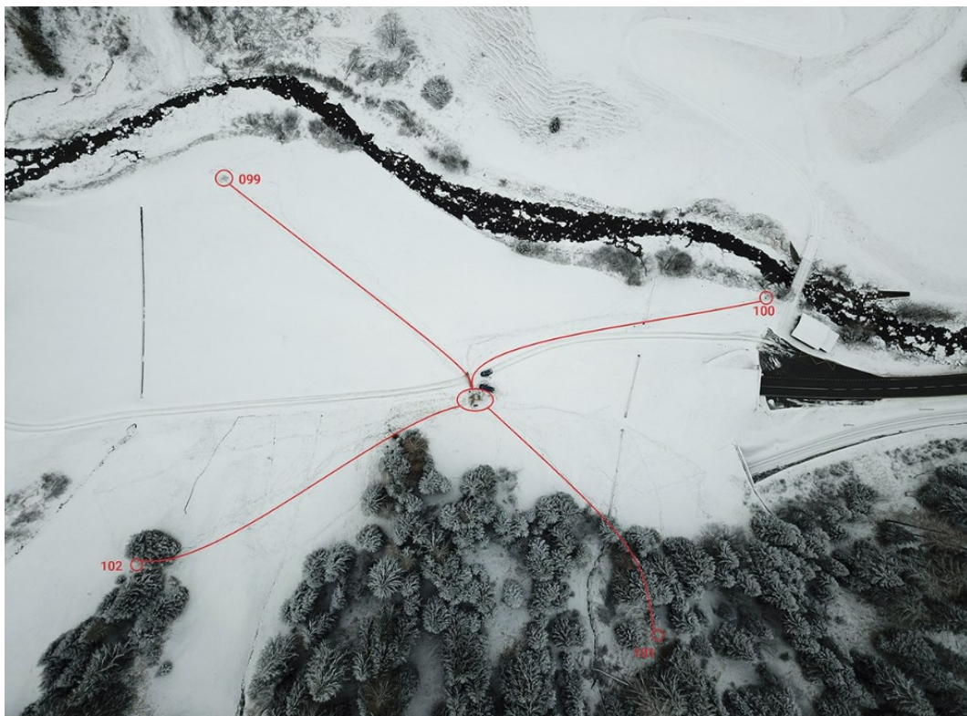
Abb. 7.40 Systemanlage Infrasound: vier Infraschall-Sensoren leiten ihre Messungen an eine zentrale Auswerteeinheit weiter [67].
