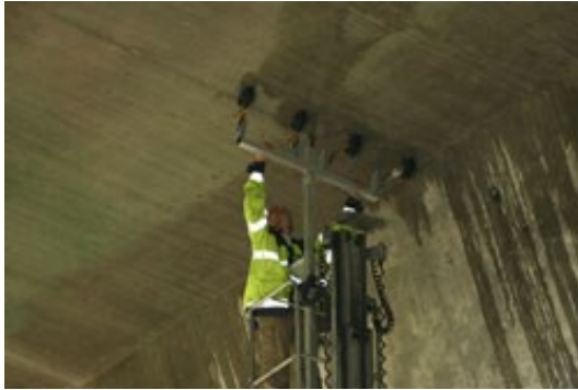
Abb. 7.86 Potentialfeldmessung an Autobahnbrückenuntersicht [167]
