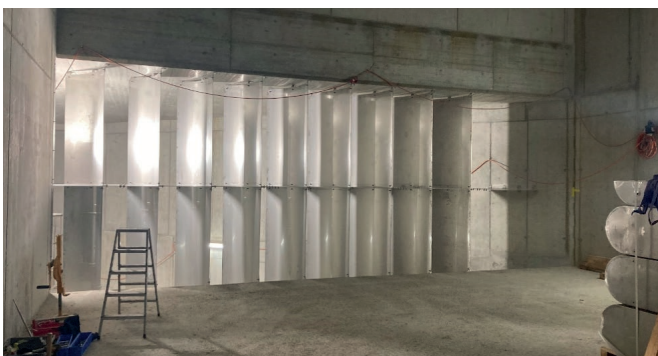
Über Bleche wird die Abluft direkter zu den Ventilatoren gelenkt.
