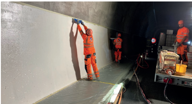
Bauarbeiter beschichten die Tunnelwände, um diese zu schützen.
