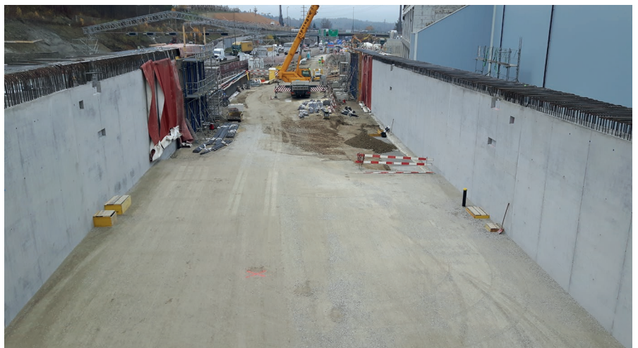
Als erster Schritt werden die Wände der Überdeckung Weiningen gebaut.
