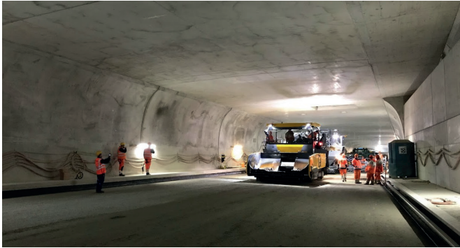
Der Einbau des Strassenbelags erfolgte im Sommer 2021.
