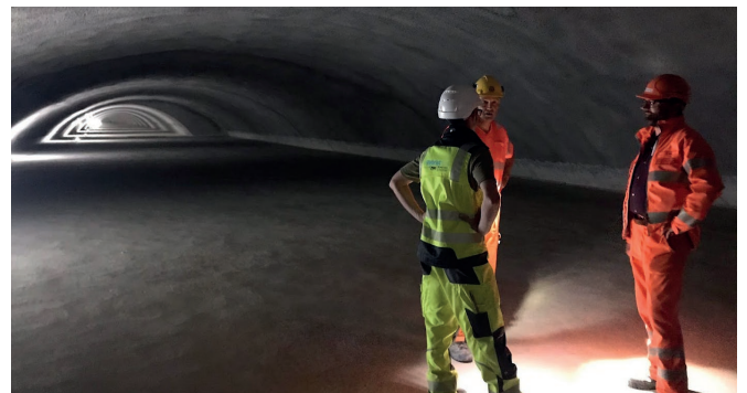
Im Abluftkanal wird bei einem Brand der Rauch abgezogen.
