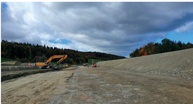
Ein Damm beim Verladebahnhof schützt die Umgebung vor Lärm.
