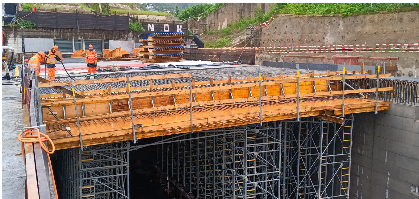
Die Seitenwände bei der Überdeckung Weiningen sind bereits hochgezogen, die Decke wird blockweise erstellt.
