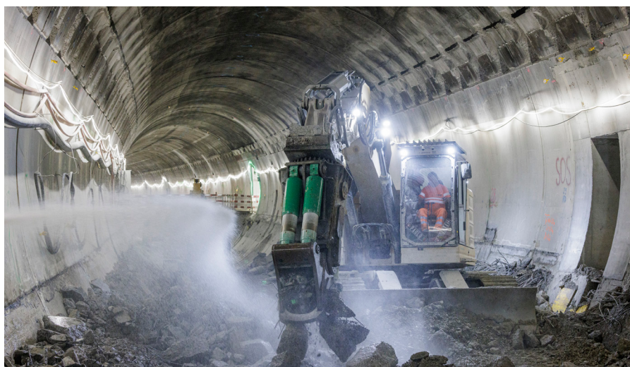
Bagger zerkleinern das Abbruchmaterial in der 2. Röhre für das Recycling.
