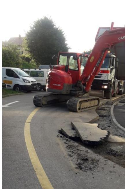
Figure 4 - Aménagements extérieurs chantier Epinettes
