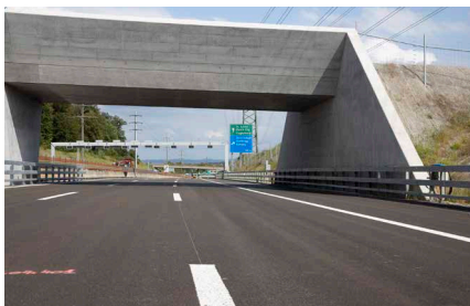
Alle Überführungen sind fertiggestellt.
