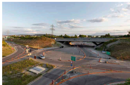
Der «Nüsslikreis» wird 2020 saniert.
