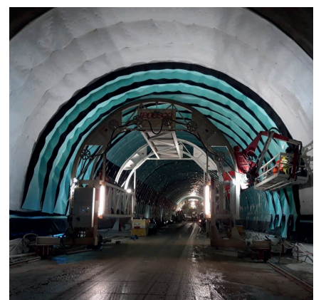
Abdichtungsarbeiten im Tunnel.
