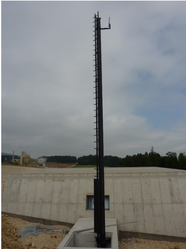
Abbildung 3.2: Antennenmast mit Schutzvorrichtung
