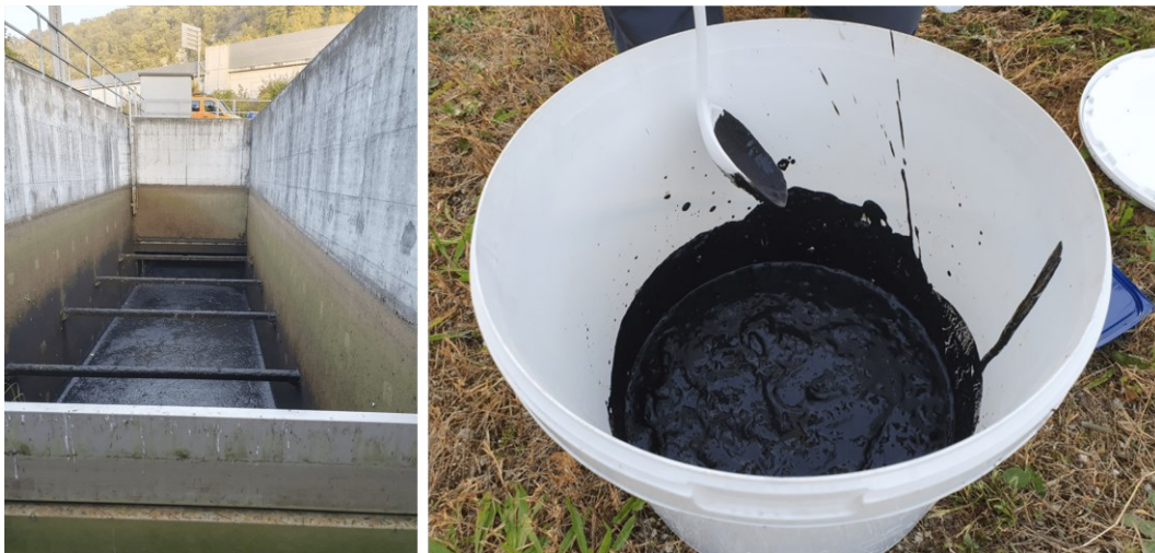
Abb. 3.2 Von Klarwasser leer gepumptes Absetzbecken der SABA Hinterborn (links), Sammelprobe aus fünf Einzelprobenahmen von der Sohle des Absetzbeckens, voraus eine Menge von 1 kg zur Analyse geschickt wurde.
