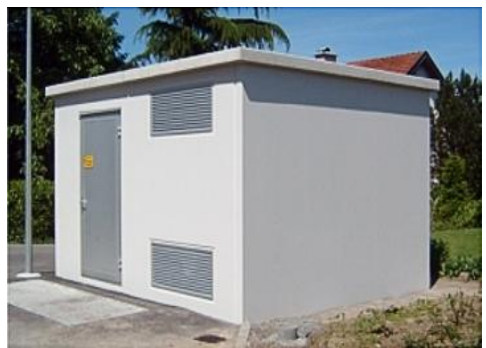
Abbildung 4: Versorgungsstation aus Beton (Beispiel)
