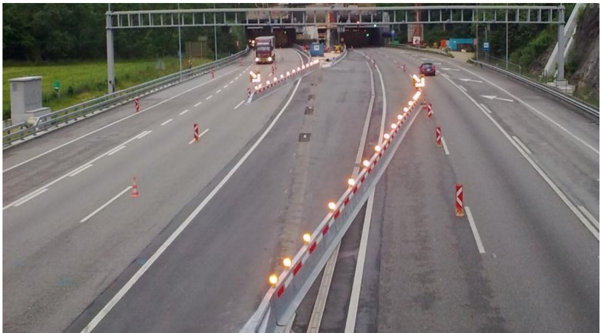
Abbildung 1: Beispiel einer Mittelstreifenüberfahrt
