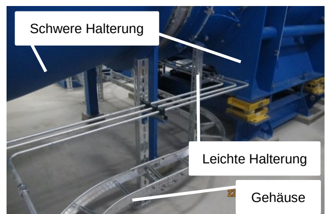
Bild 15: Detailansicht Axialventilator
