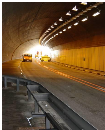
Zone 20: Fahrbahnbereich Tunnel
