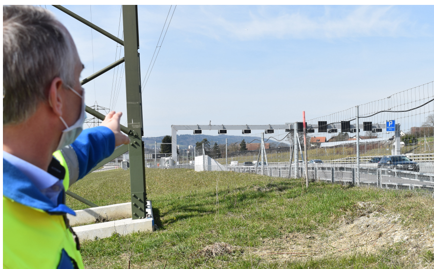
Georg Hiestand vor den neuen Signalanlagen auf der Nordumfahrung Zürich. Sie erleichtern die Verkehrslenkung und warnen die Verkehrsteilnehmenden vor Staus oder Unfällen.
