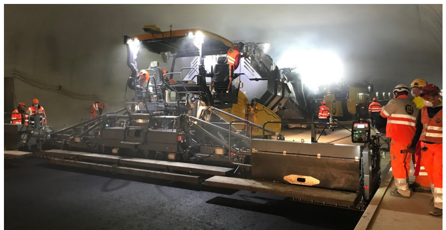
Ein Strassenfertiger baut den Belag von der Tunnelmitte in Richtung Portalbereich Affoltern.
