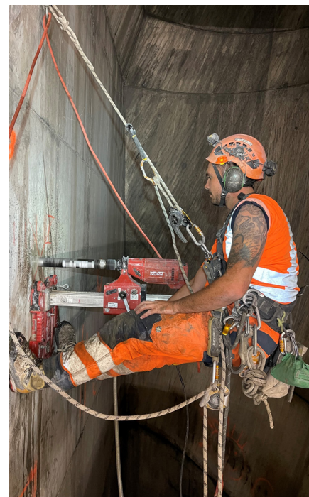
Abseilen im obersten Teil des Abluftschachtes beim Auslass auf dem Gubrist für dessen Zustandserfassung.
