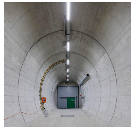
Befahrbarer Querschlag zwischen 2. und 3. Tunnelröhre
