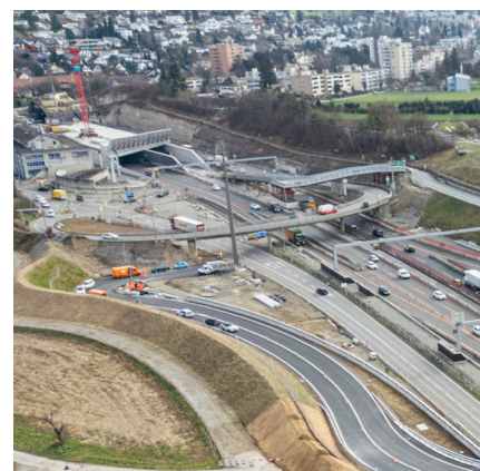
Alte Einfahrtsrampe mit Logistikbrücke in Weiningen
