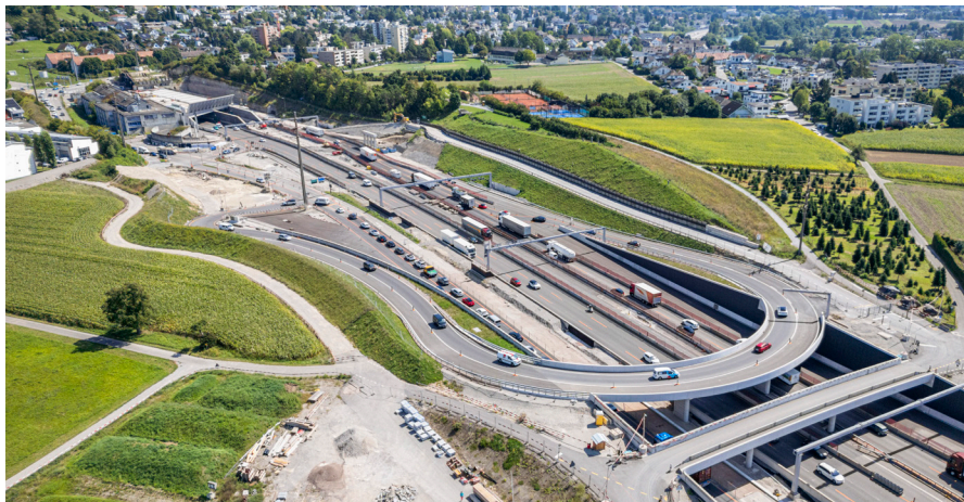
Neue Einfahrtsrampe ohne Logistikbrücke in Weiningen
