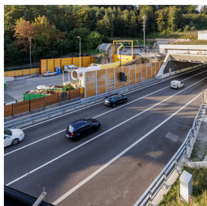
Tunnelportal 3. Röhre Affoltern
