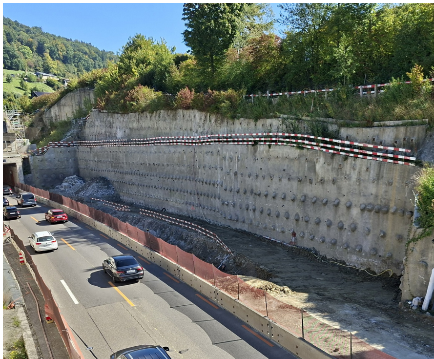
Vorarbeiten 1. Röhre Tunnelportal in Weiningen
