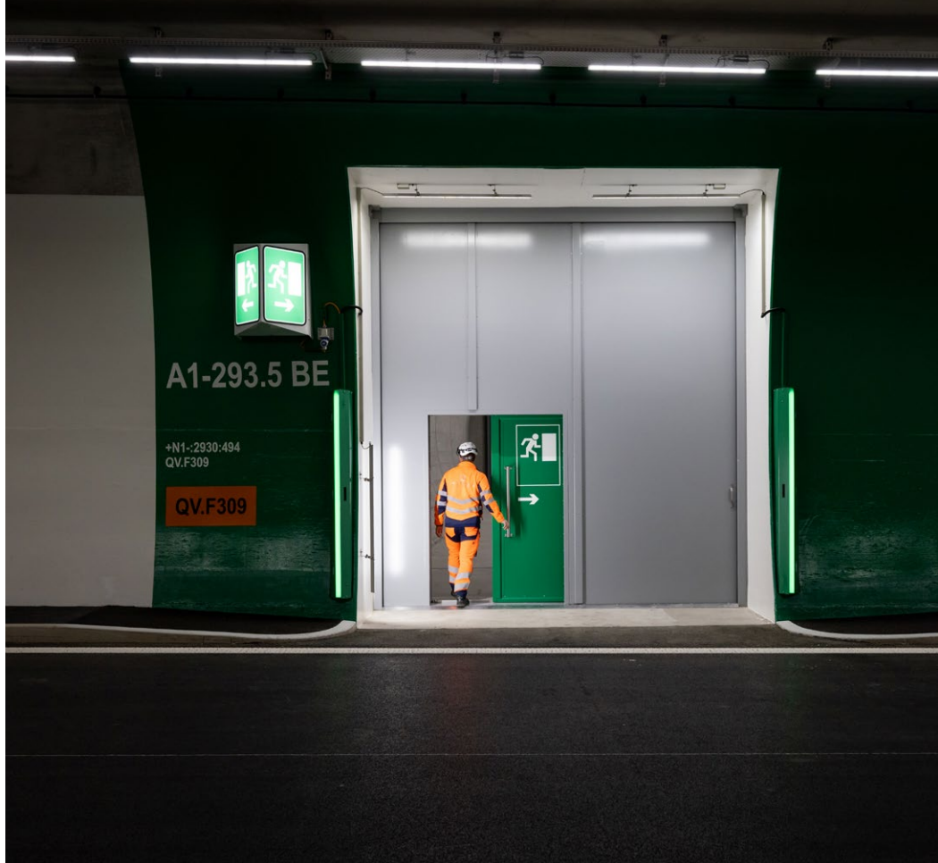
Zugang zum Rettungsstollen in der 3. Röhre des Gubristunnels.
