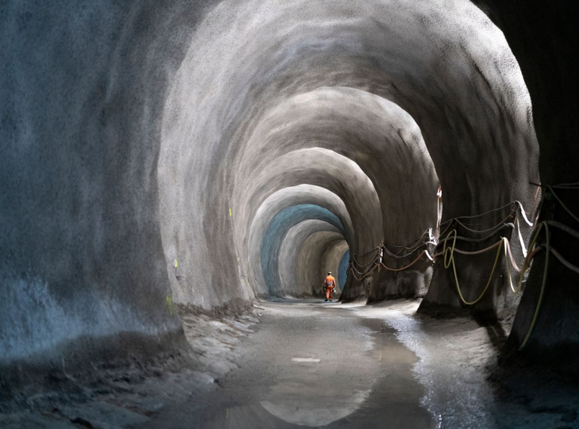
Mineure arbeiten im Sicherheitsstollen der zweiten Röhre des Gotthard Strassentunnels.
