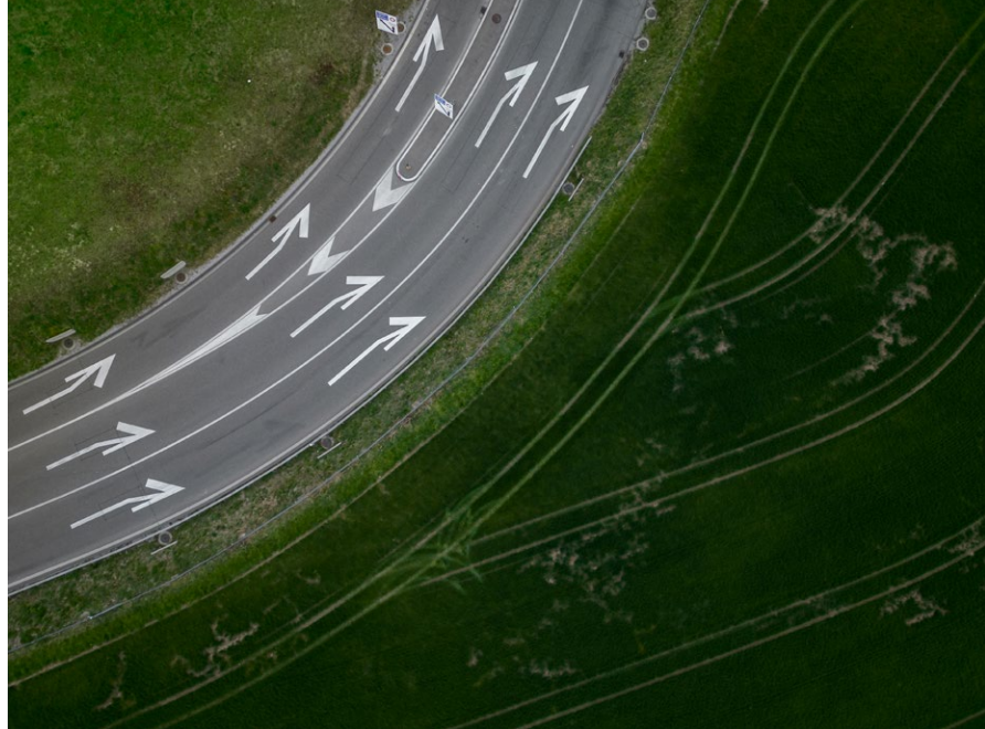
Ausfahrt Regensdorf der Nationalstrasse A1 auf Höhe Zürich-Affoltern.
