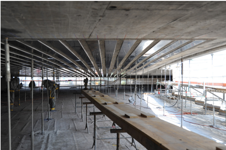
Carbonfaser verstärkte Kunststofflamellen (CFK Lamellen) als Massnahme zur Unterstützung der Statik
