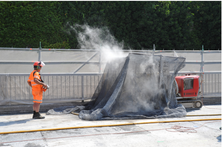
Hochdruckwasserstrahl-Arbeiten mit 5'000 Bar und Mithilfe eines Roboters
