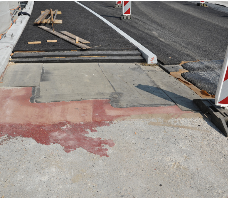
Fahrbahnaufbau (rote Versiegelung, Teerpappen, Gussasphalt)
