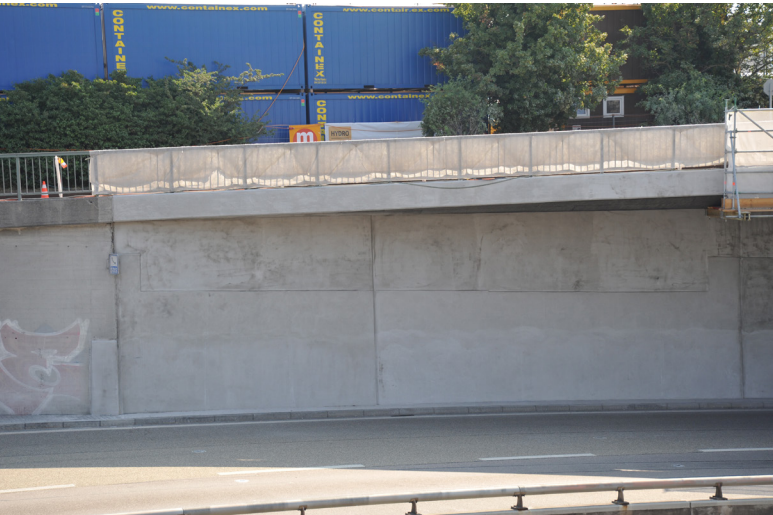
Sauber verputzt nach Erhaltungsarbeiten
