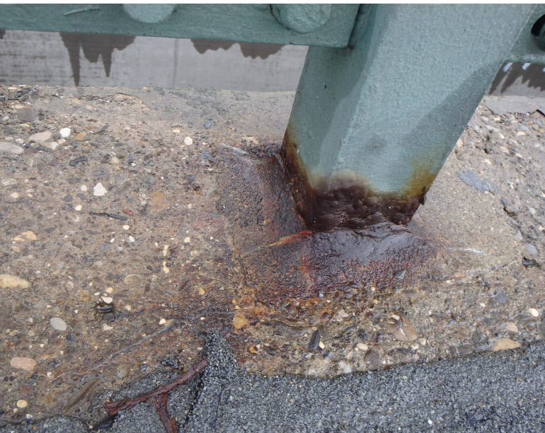
Geländerpfosten auf der aufgeständerten Schwarzwaldallee
