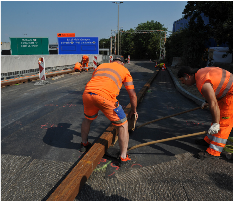
Vorbereitungsarbeiten für die maschinelle Belagsaufbringung
