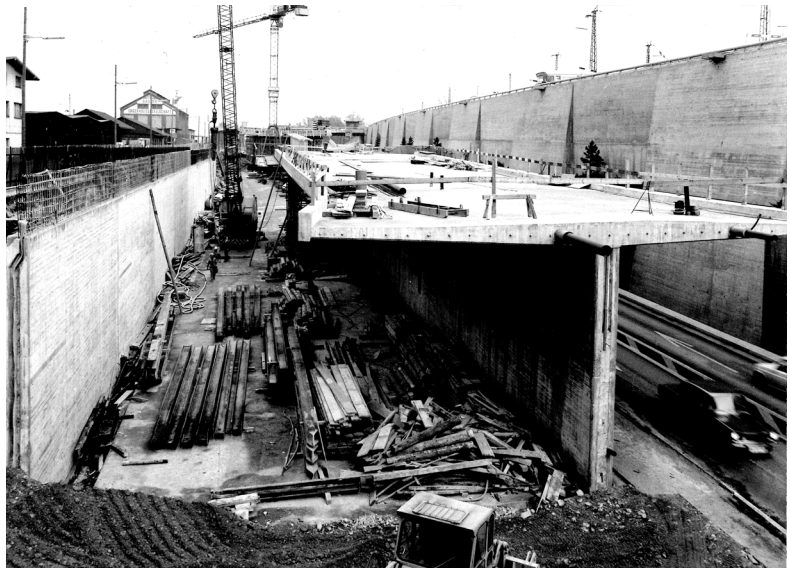
Die Bauarbeiten vor über 40 Jahren - ein Grossprojekt für Basel (Bild zeigt ein Teil der Nordrampe West)
