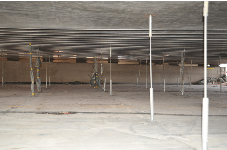
Arbeitsebene des Unterbaugerüsts
