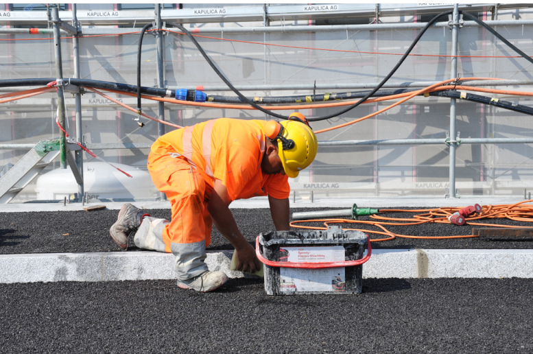
Fugenarbeiten bei den Randsteinen
