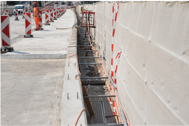
Seitliche Sicht auf das Unterbaugerüst
