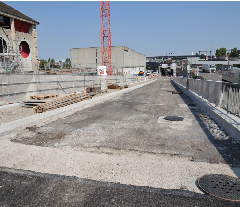
Für Belagsarbeiten vorbereitete Nordrampe
