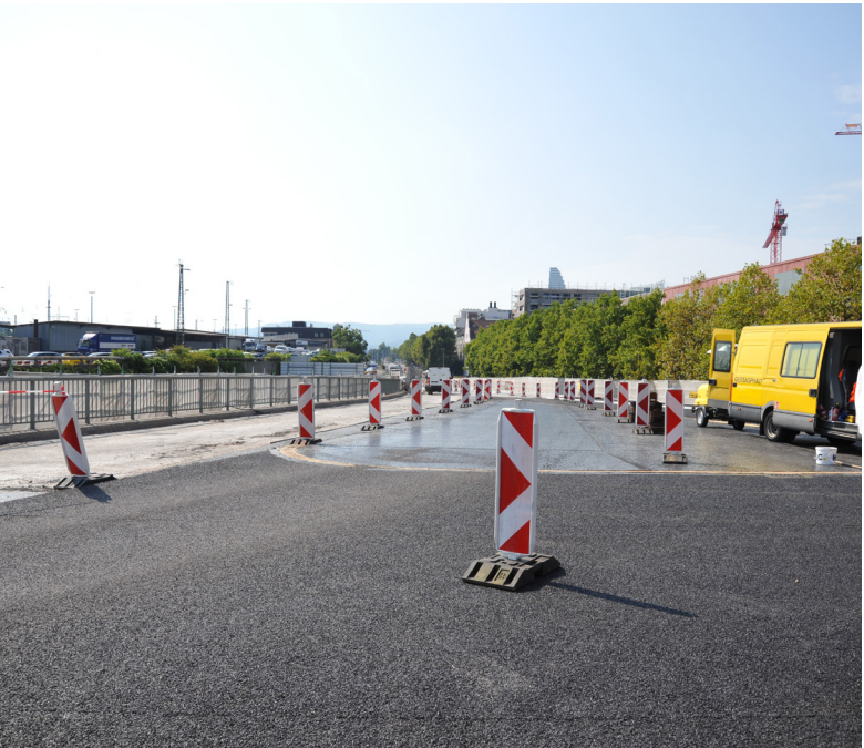
Südrampe mit teilweise neuem Fahrbahnbelag
