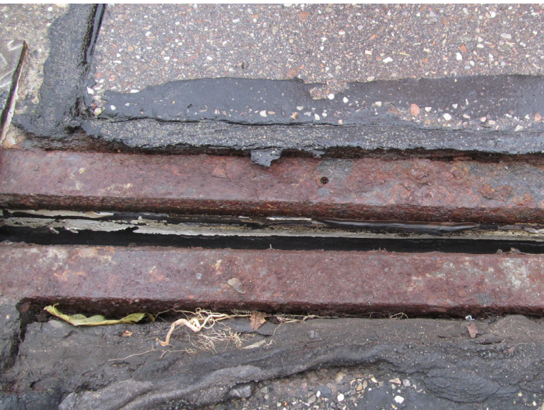
Fahrbahnübergang der aufgeständerten Schwarzwaldallee
