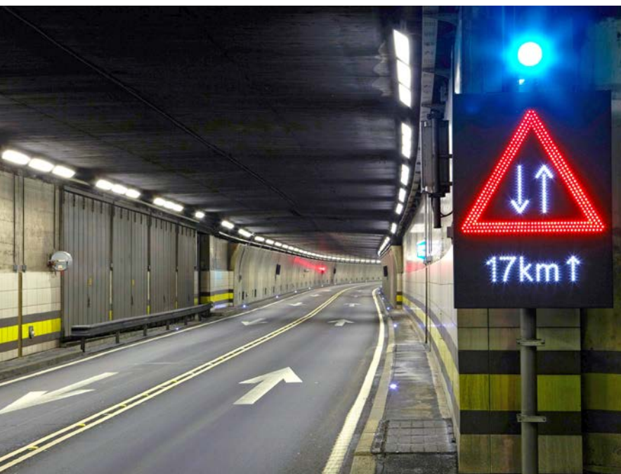
A2, Gotthard-Strassentunnel mit Gegenverkehr.
