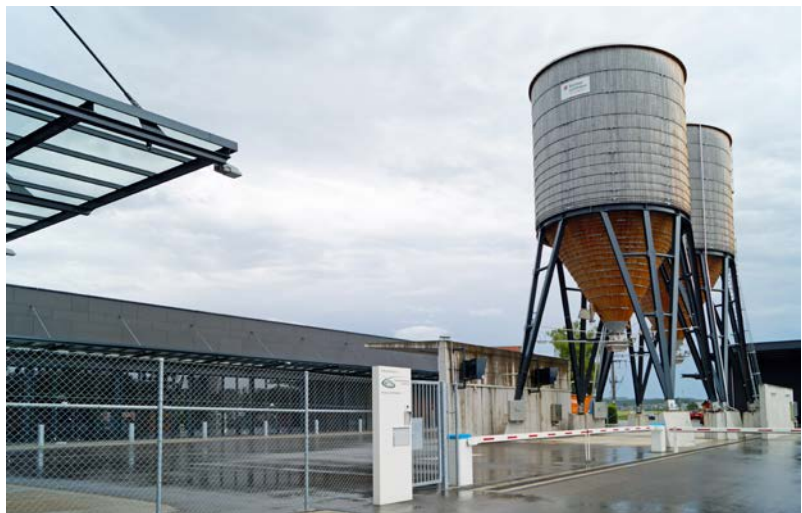
Moderne und digitalbedienbare Salzbefüllungsanlage am Stützpunkt Müllheim.
