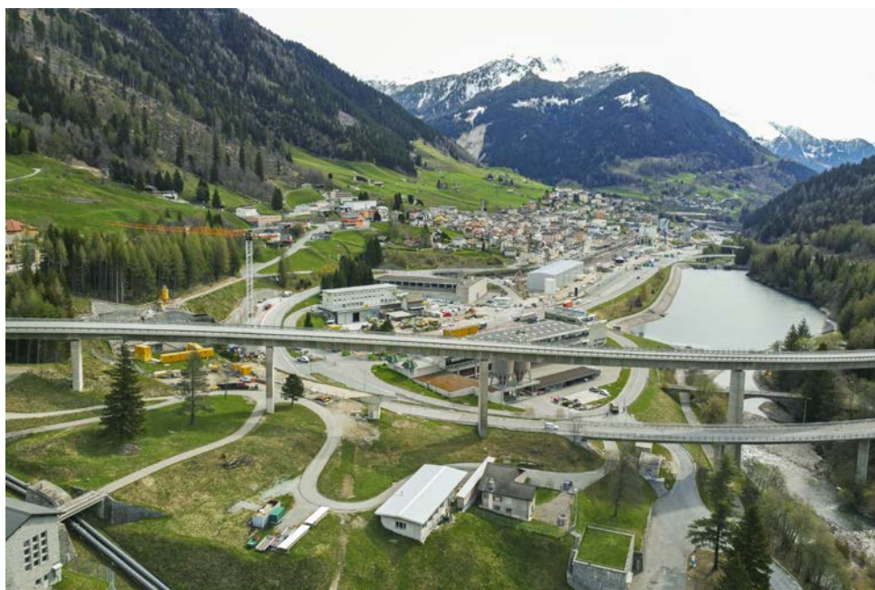
Baustelle der zweiten Röhre des Gotthard-Strassentunnels in Airolo.
