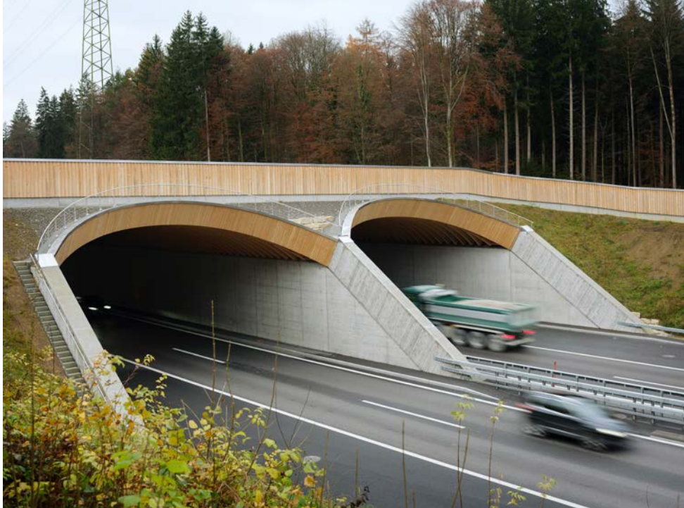
Bepflanzte Wildtierüberführung über die A1 bei Suhr.
