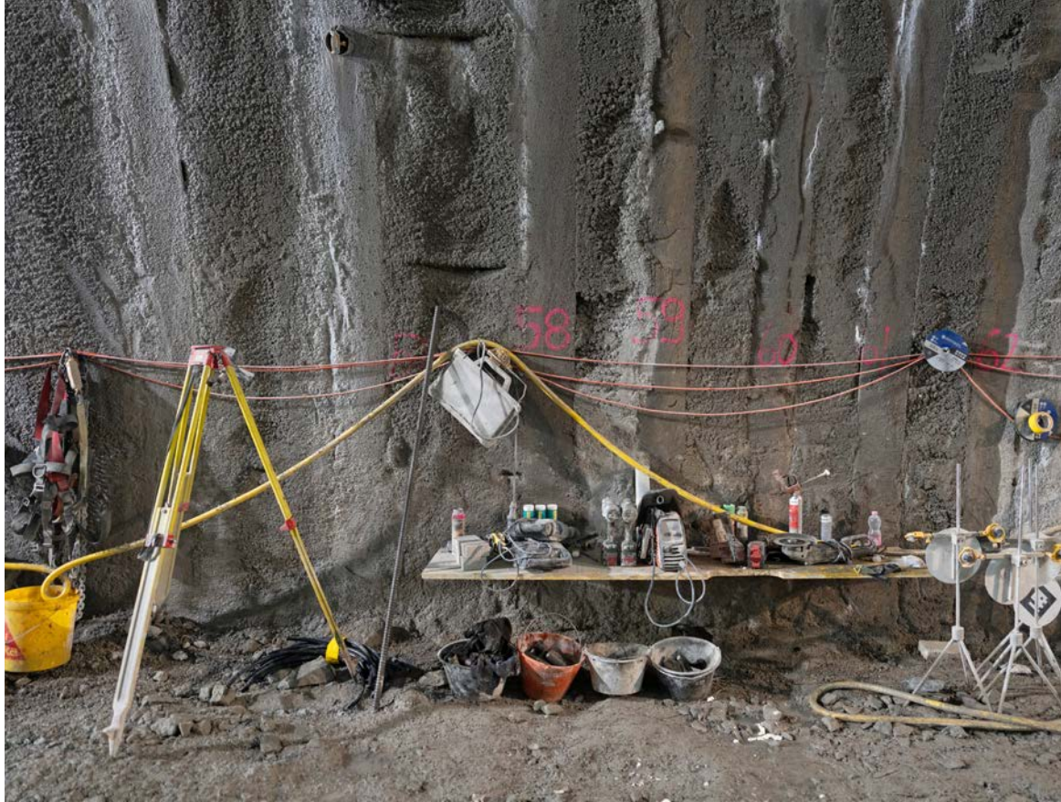
Arbeitsgeräte der Mineure in Airolo.
