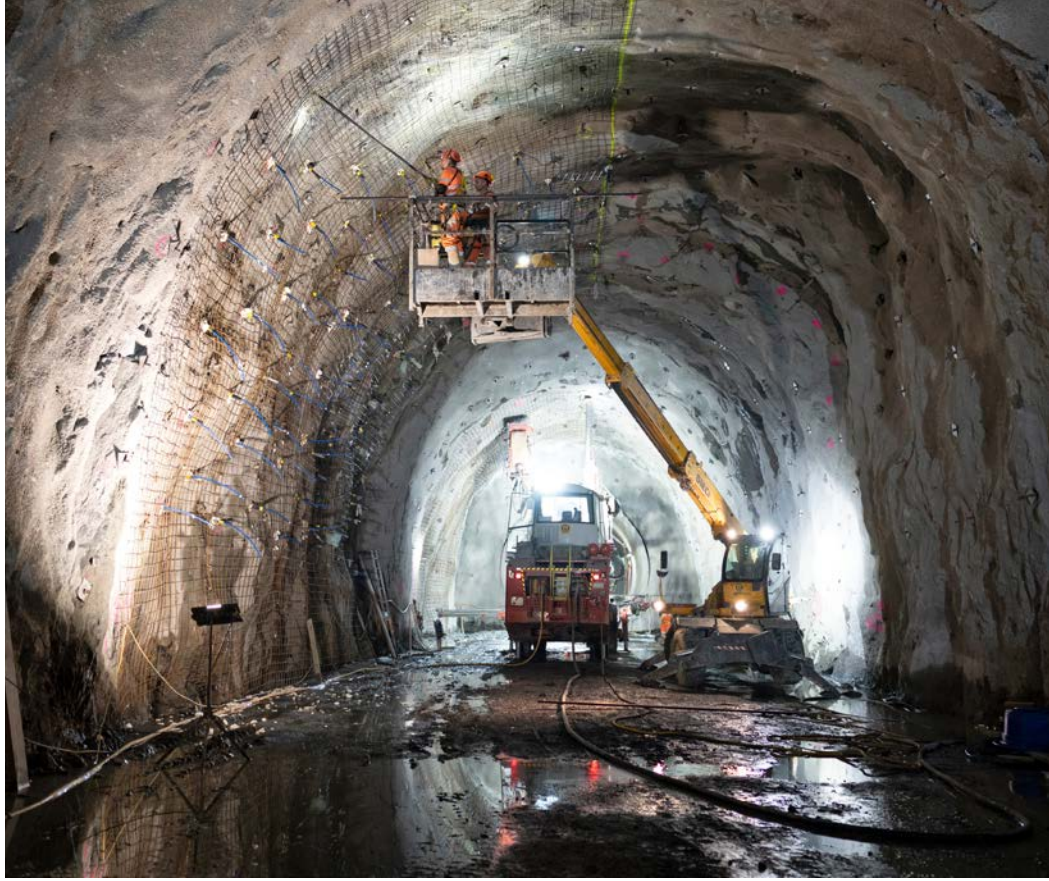
Sicherungsarbeiten an den Wänden der Logistikkaverne, von der aus Mineure einen 300 Meter langen Abschnitt der zweiten Röhre des Gotthard-Strassentunnels sprengen.
