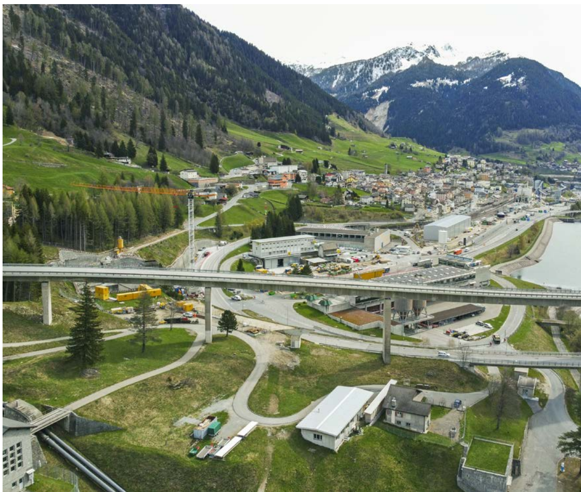
Baustelle der zweiten Röhre des Gotthard-Strassentunnels.
