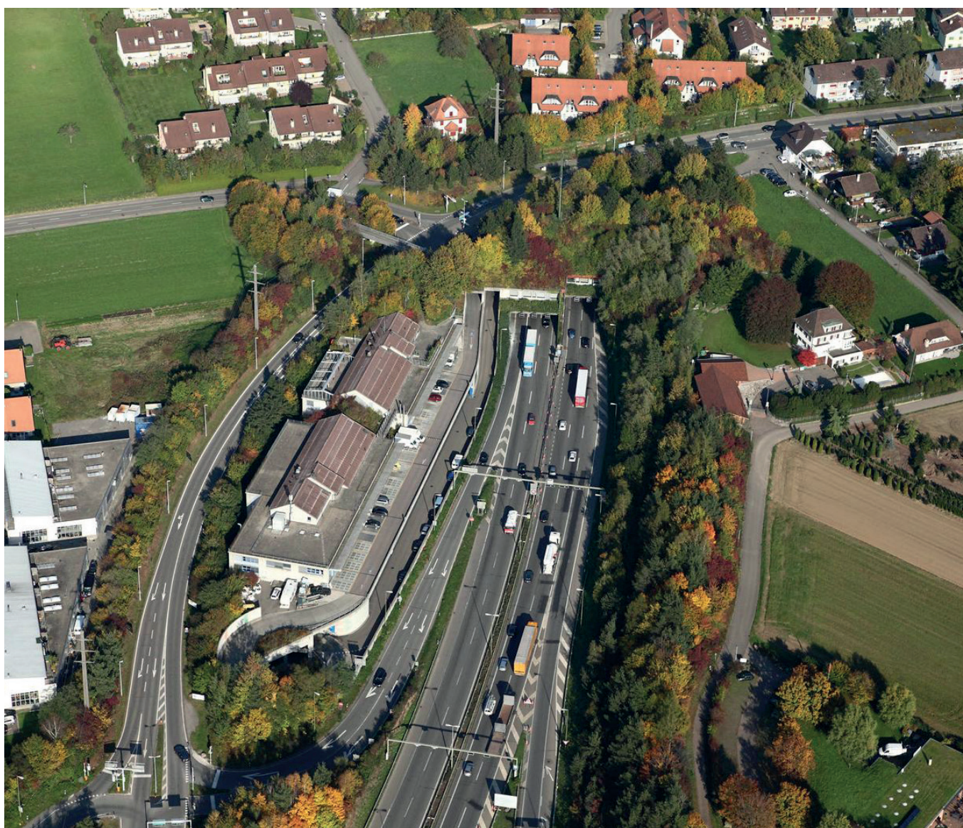
Blick auf das Westportal des Gubristtunnels bei Weiningen mit der Umfahrungsstrasse (links der Autobahn hinter dem Gewerbehau) und der Zürcherstrasse (nördlich der Autobahn).
