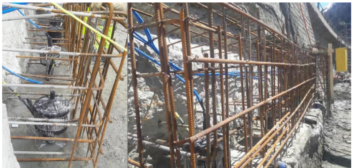
Abbildung 3: Beispiel einer Fundamentverstärkung mit überwachbaren Mikropfählen
