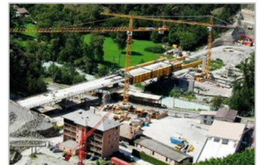
Abbildung 3: Kolkschutz (A9 Umfahrung Visp VS)
