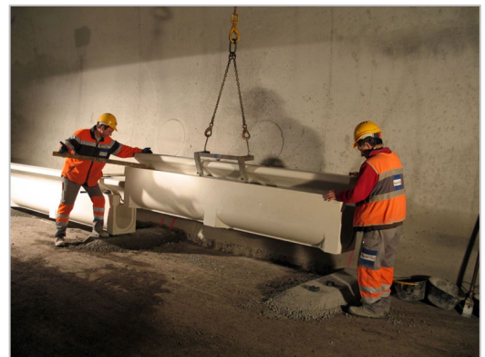
Abbildung 5: a) Beispiel Schlitzrinne b) Beispielfoto Schlitzrinne c) Beispielfoto Schlitzrinne verlegen
