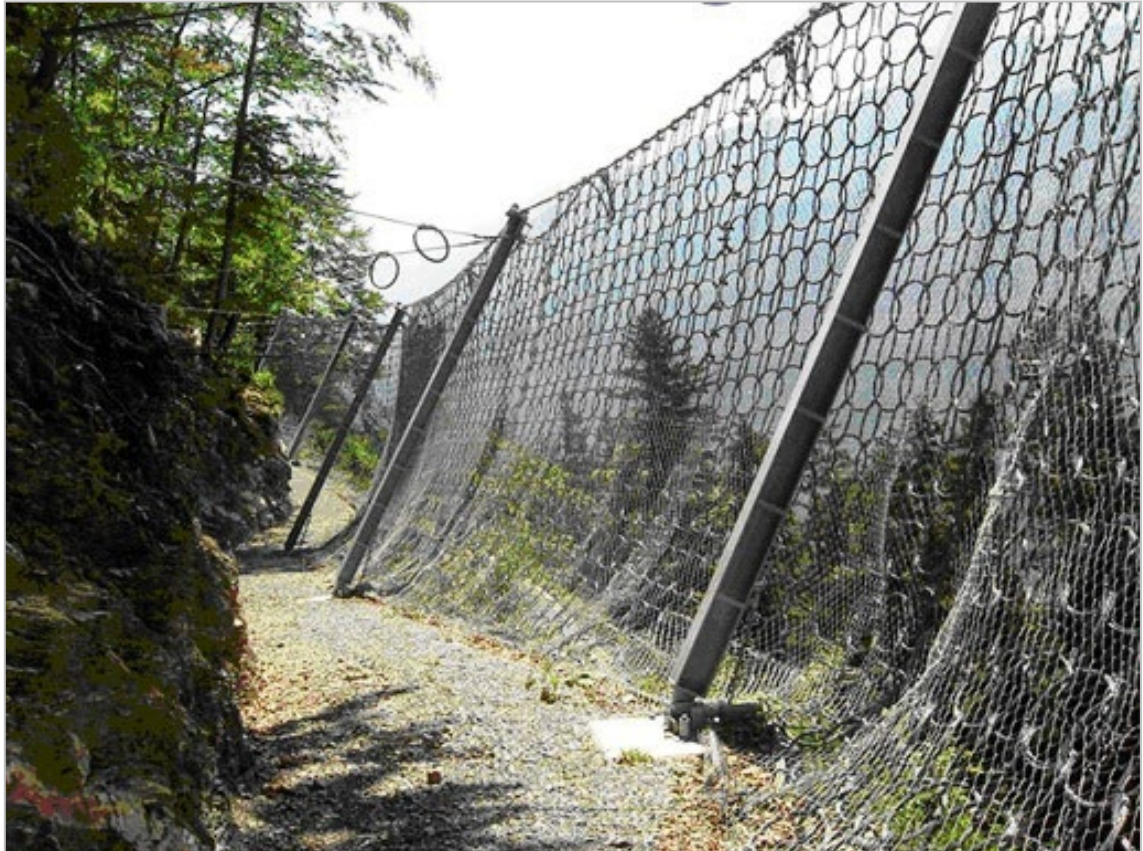
Abbildung 1: Steinschlagschutznetz entlang der Brünigstrecke mit Unterhaltsweg
