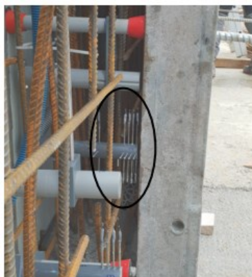
Abb. 8.174 Beispiel für die Korrosionsüberwachung an Betonstrukturen. (Quelle: [476])
