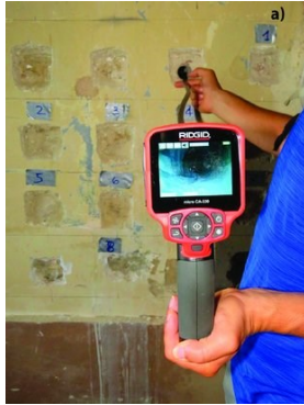
Abb. 7.80 Endoskopische Prüfung an einem Mauerwerk mit einem Videoendoskop RIDGID micro-CA 330 [230]
