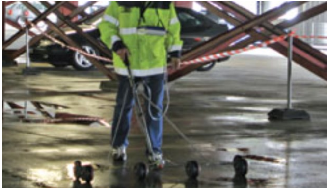
Abb. 7.126 Potentialfeldmessung auf einer Parkplatte (Quelle: mt-qualitest.ch)
