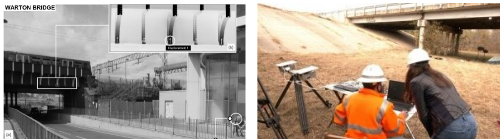
Abb. 7.85 Beispiel einer Brückenüberwachung mit DBK. Bild wiederverwendet aus [252]
