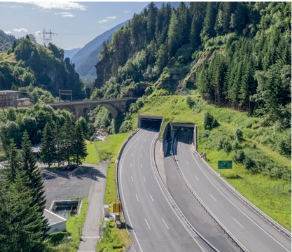
Galleria Stalvedro Nord-Sud: ampliamento
