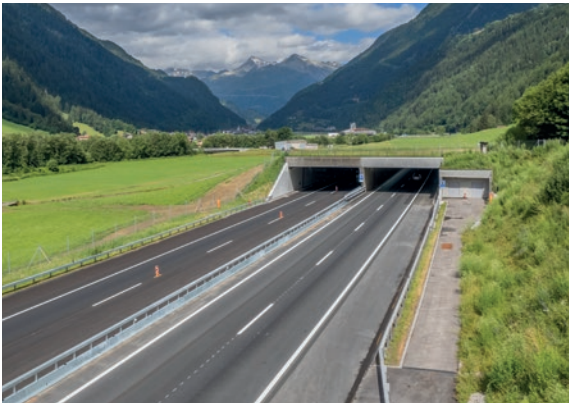
Galleria Quinto Sud-Nord: risanamento
