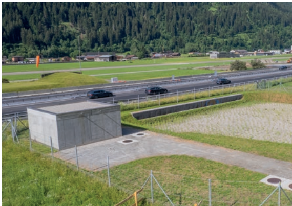
Impianto trattamento acque Ambri
