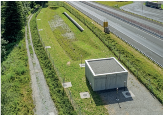
Impianto trattamento acque Piotta
