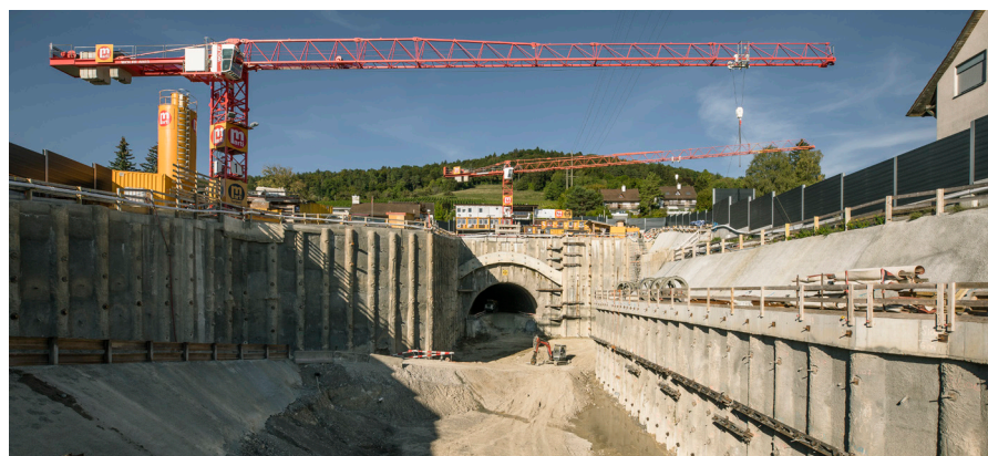
Die bergmännischen Tunnelarbeiten auf der Weinger Portalseite sind abgeschlossen.
