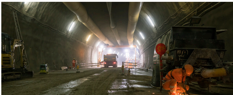
Rund 120 Tunnelbauer stehen für den Bau der 3. Gubriströhre im Einsatz.
