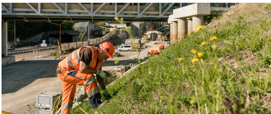
Gezielte Bekämpfung der Neophyten auf der Baustelle beim Tunnelportal in Affoltern.
