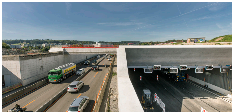
Der erste Teil der Überdeckung Katzenssee auf der Fahrspur in Richtung Bern ist fertig.
