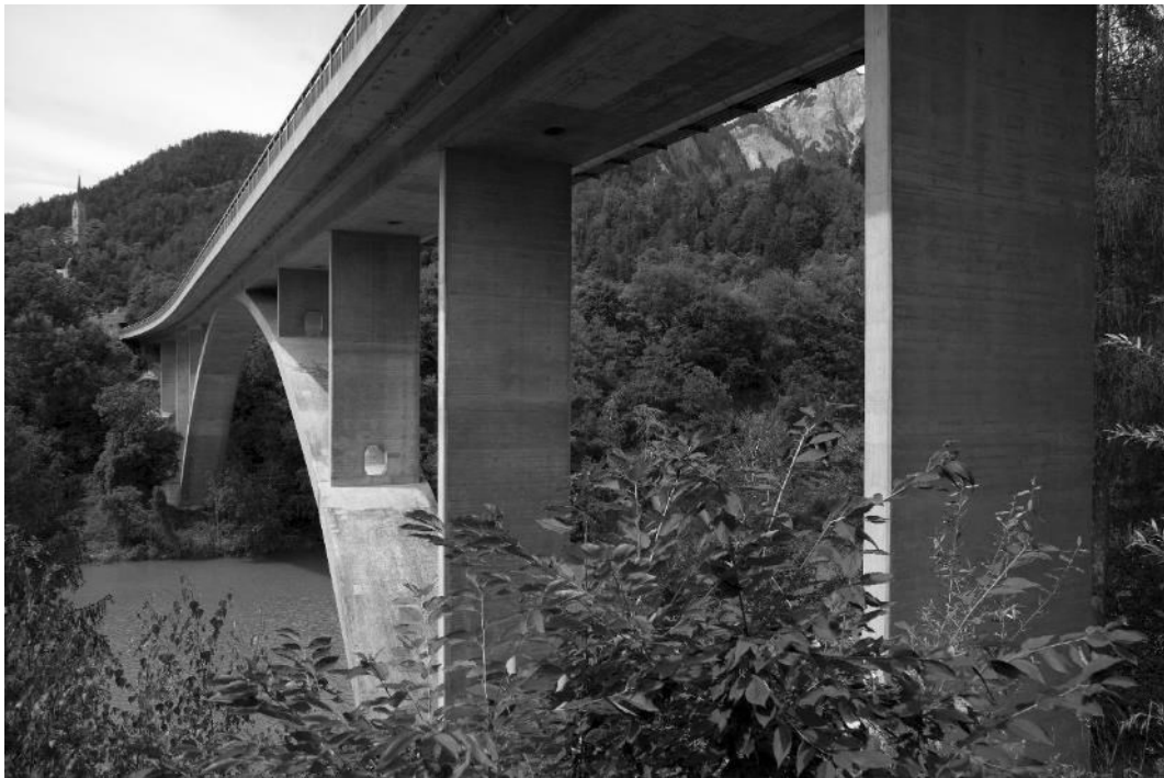
Abb. III.2 Rheinbrücke Reichenau (Oberalpstrasse), GR. © Ikiwaner / Wikimedia Commons ID: 213022.
