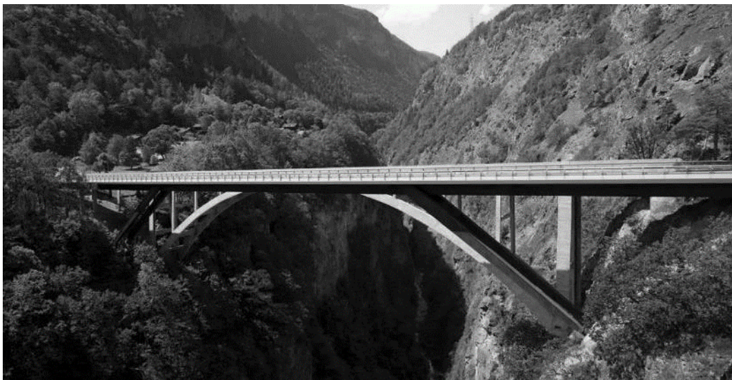
Abb. III.9 Pont de Gueuroz nach der Erstellung des neuen Bauwerks, VS. © Commune de Vernayaz
