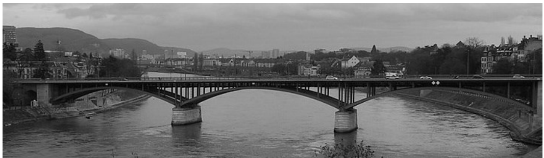
Abb. III.11 Wettsteinbrücke Basel, BS: neue Brücke. © Marc Annaheim
