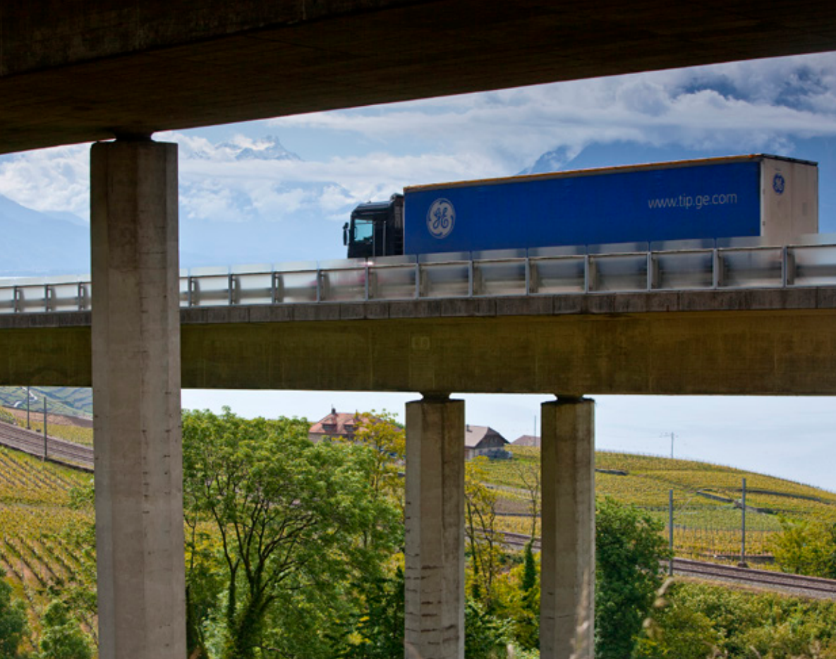
Lastwagen auf einer Brücke der A9 im Lavaux bei Pully.
