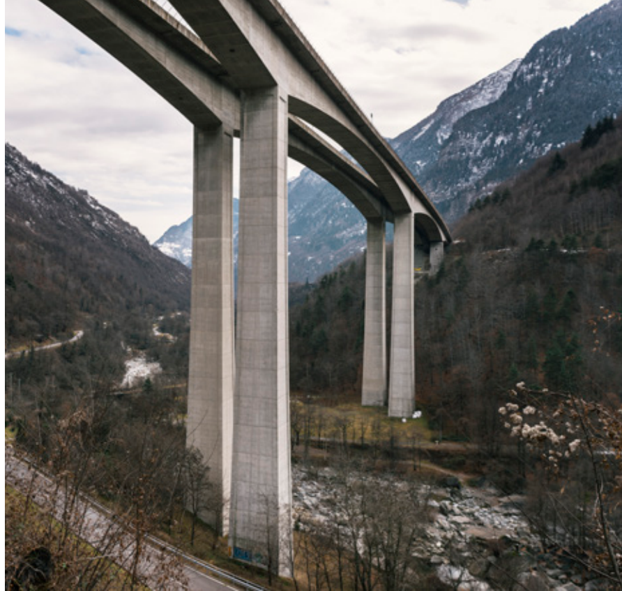
Das Biaschina-Viadukt, Bestandteil der Autobahn A2, bei Giornico in der Leventina im Kanton Tessin ist mit 110 Meter das zweithöchste Brückenbauwerk der Schweiz.
