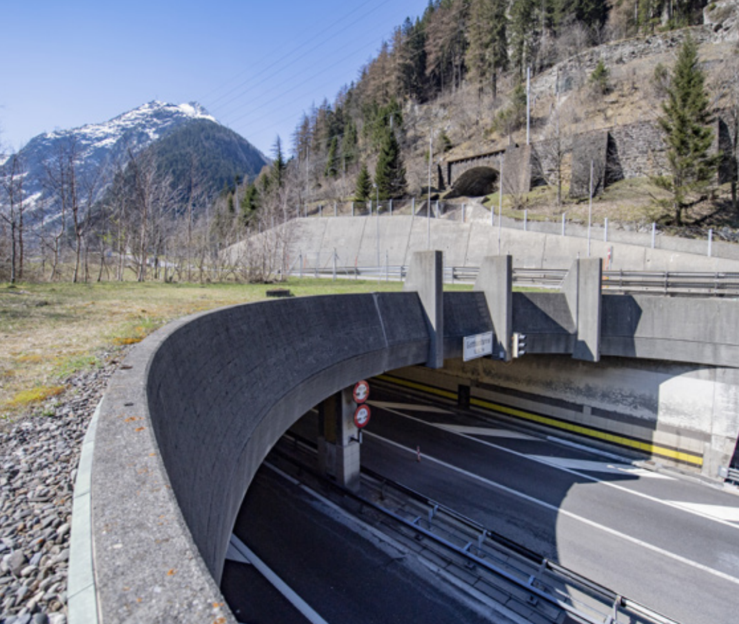
Nordportal des Gotthardtunnels auf der A2 bei Göschenen. Blick Richtung Süden.
