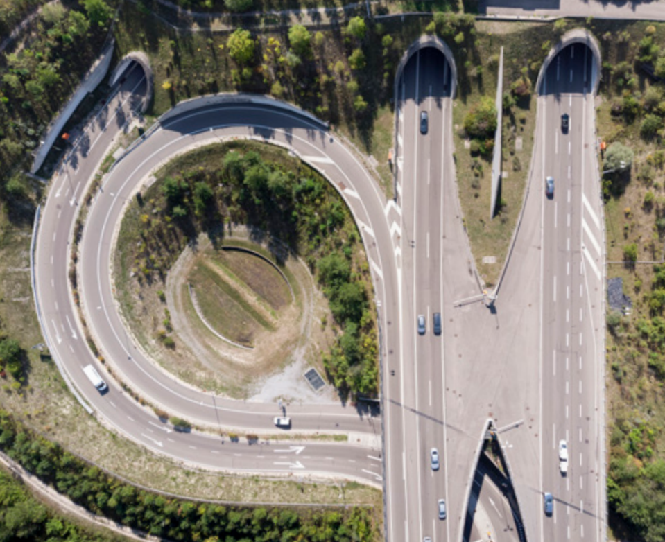
A3 und Portal des Aeschertunnels. Drohnenaufnahme bei Birmensdorf aus dem Jahr 2018.
