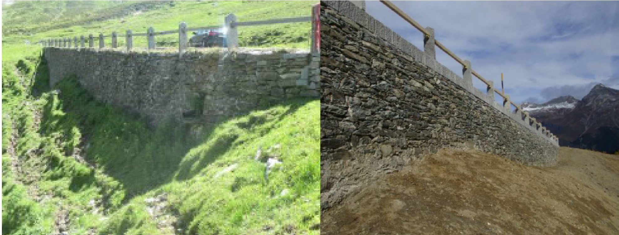
Splügenpass. Situation vorher und nachher, mit neuem Natursteinkordon
