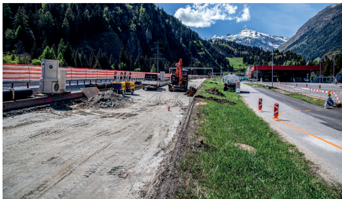
Rifacimento dell'uscita verso l'area di servizio Stalvedro.
