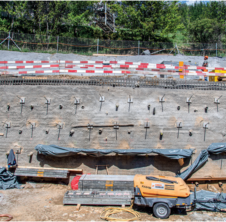
Galleria artificiale di Quinto: scavo per la nuova centrale tecnica.
