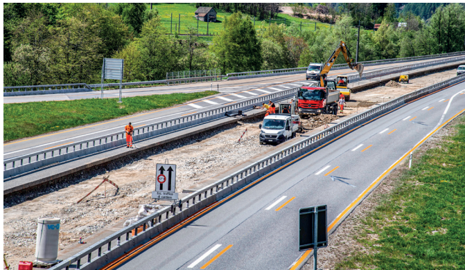
Lavori nello spartitraffico centrale zona Varenzo.
