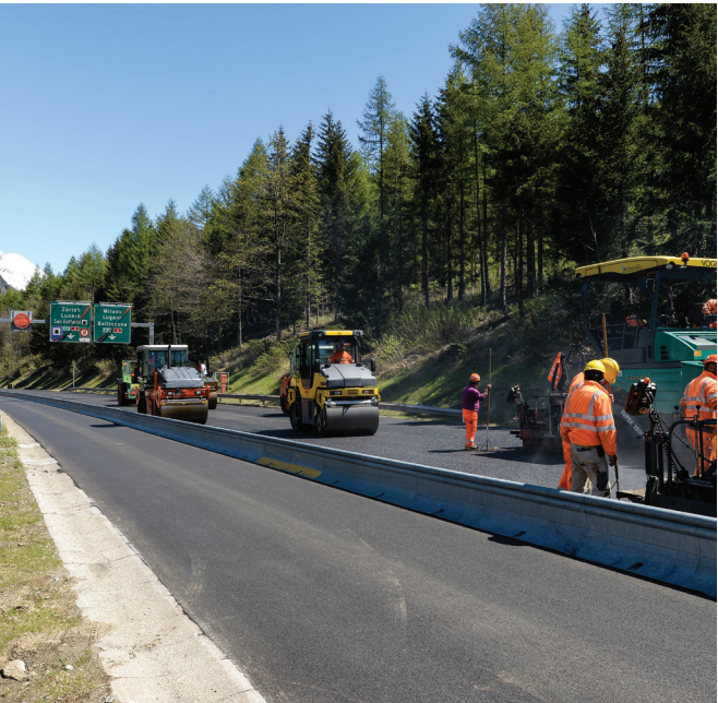
Lavori sul comparto Airolo zona svincolo.
