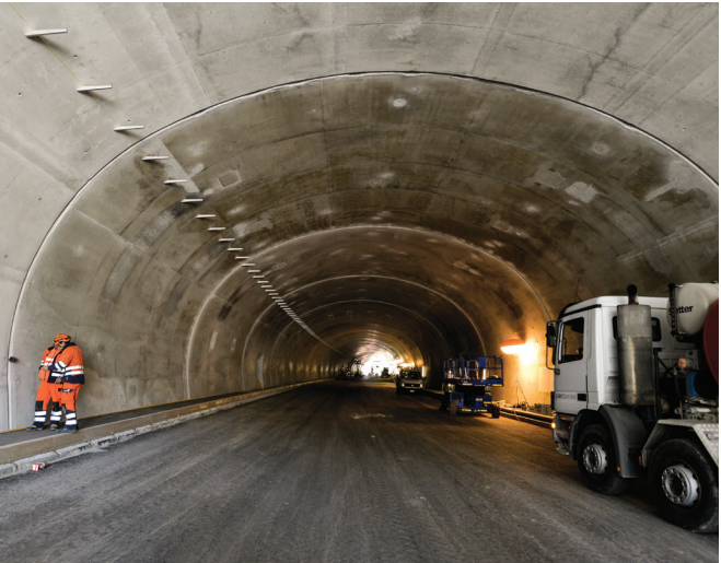
Interno della galleria S-N dello Stalvedro a lavori quasi ultimati.
