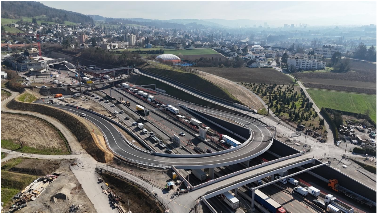
Die neue Anschlussrampe Weiningen, im Vordergrund ist die neu gebaute Überführung Klosterweg zu sehen.
