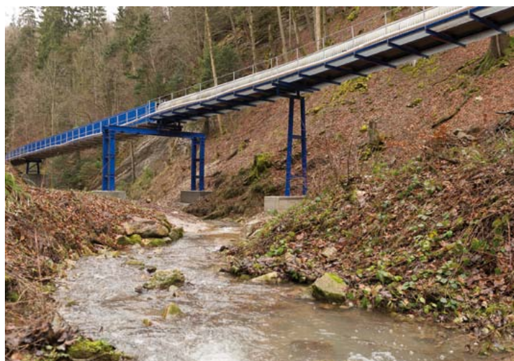
Das 1100 Meter lange Förderband für den Abtransport des Ausbruchmaterials in die Deponie Fasiswald ersetzt umweltbelastende Lastwagenkonvois.
