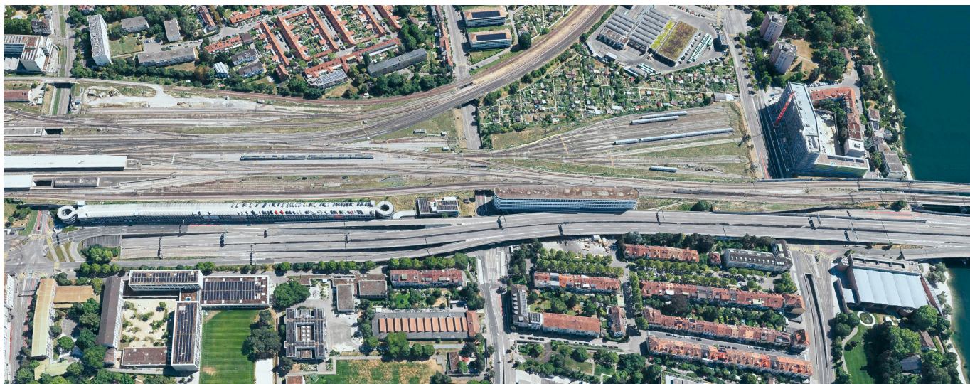
Die A2 zwischen dem Tunnel Schwarzwald und der Schwarzwaldbrücke: Hier findet ein Grossteil der nächtlichen Vorbereitungsarbeiten statt.
