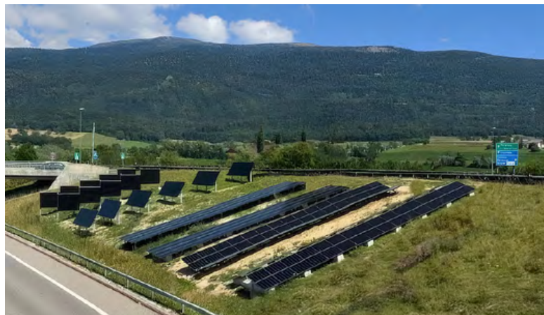
Testlauf: Das ASTRA prüft an der A16 bei Delsberg-West den Einsatz von Photovoltaik auf Autobahnböschungen.
