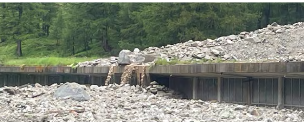
Ende Juni 2024 verschüttete ein Murgang am Simplonpass die Nationalstrasse und drang in die Galerie Engi ein.
