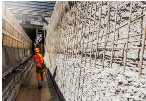
Für Brücken, Stützmauern und weitere Gewerke im Strassenbau werden in der Regel Stahlarmierungen verwendet (vgl. Kasten).
