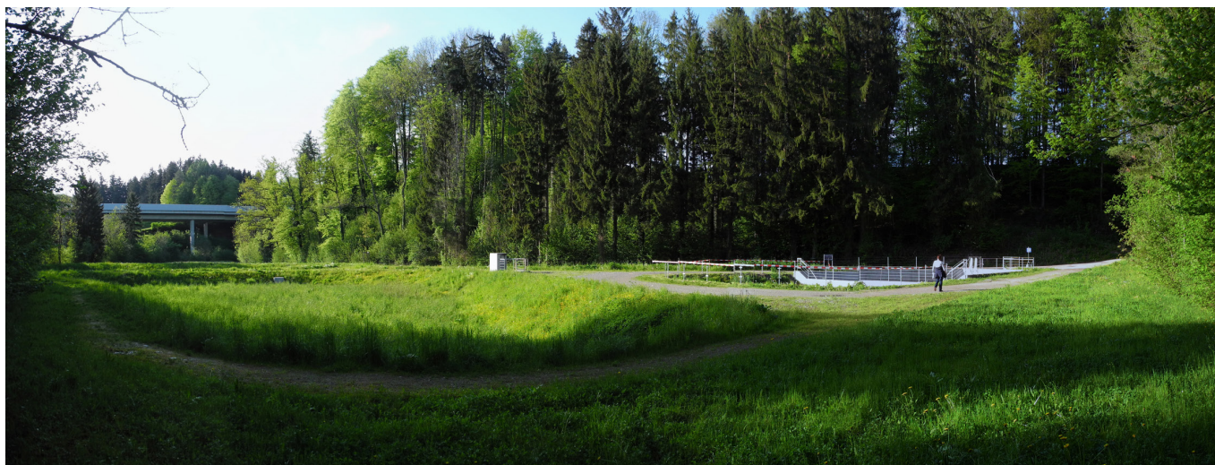
Beispiel einer Strassenabwasserbehandlungsanlage (Wässermatt an der Autobahn A4 im Raum Hedigen/Zwillikon).
