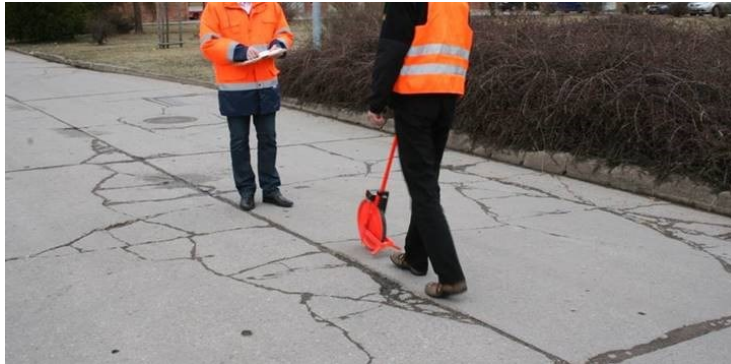
Abb. 7.97 Darstellung des Prozesses der Vermessung während einer Begehung (Kontrolle/Aufmass)
