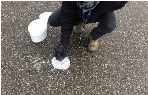
Abb. 7.21 Sandflächenverfahren, ausbringen und verteilen des Materials mit einem speziellen «Hartgummi-Verteilerscheibe» Quelle: [Fa. Nievelt]
