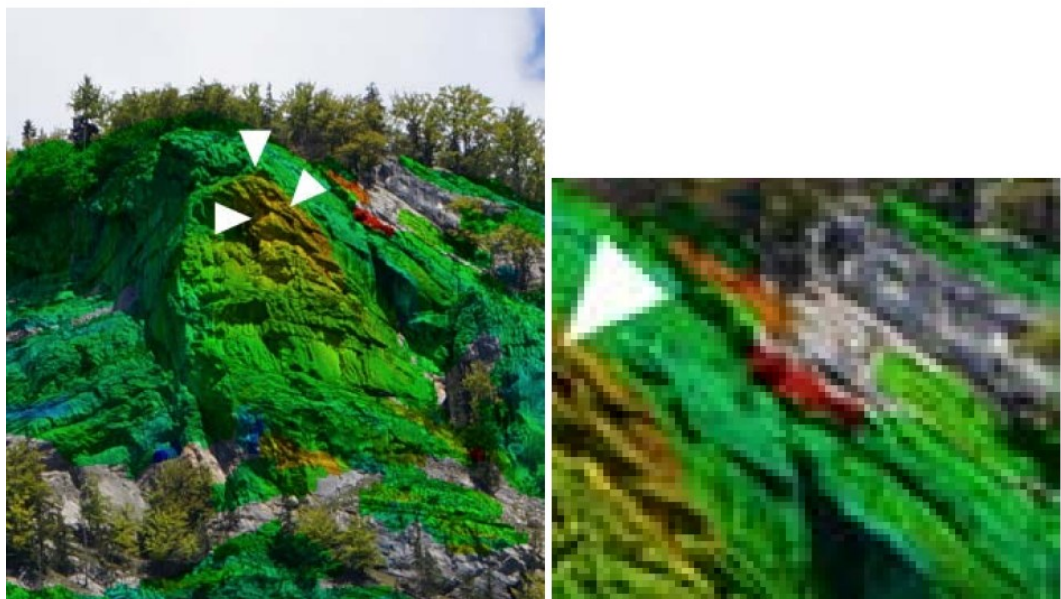
Abb. 7. Überwachung eines Felspfeilers mittels terrestrischer Radarinterferometrie. In grün und blau sind diejenigen Bereiche eingefärbt, die keine Bewegungen zeigen. Gelb und orange eingefärbt sind Gebiete, die schwache Bewegungen zeigen, in rot ist eine Felsschuppe erkennbar, welche sich seit der letzten Messung markant bewegt hat oder schon abgebrochen ist. [108].
