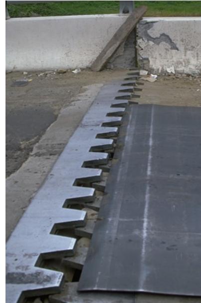
Abb. 3.11 Beschädigte Fahrbahnübergänge nach dem Erdbeben in Taiwan 1999 [30].
