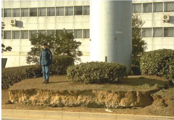
Abb. 3.16 Grossflächige Setzungen infolge Bodenverflüssigung um die Pfahlkopfplatte einer Brückenstütze, Kobe 1995 [30].
