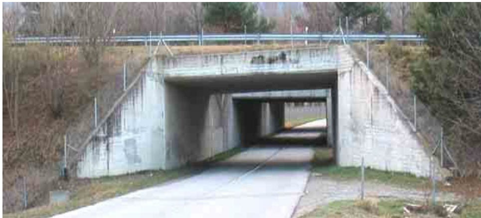
Abb. 5.3 Bei der 1. Stufe der Beurteilung wurden im Boden eingebettete, monolithische Rahmenbrücken als genügend erdbebensicher ausgeschieden [30].
