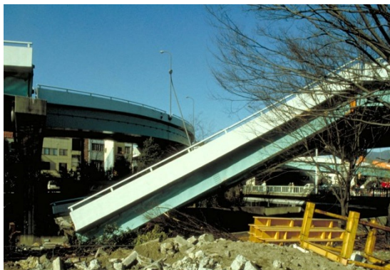
Abb. 3.1 Absturz eines Brückenträgers beim Erdbeben in Kobe 1995 (links) und in Chile 2010 (rechts) [30].
