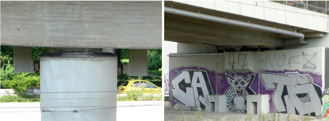
Abb. 10.7 Ertüchtigung durch Wechsel von fester zu schwimmender Längslagerung: umgebautes Widerlager mit vertikalen Stangen als Zuglager (rechts); neue seitliche Nocken bei einer der beiden Mittelstützen (links).
