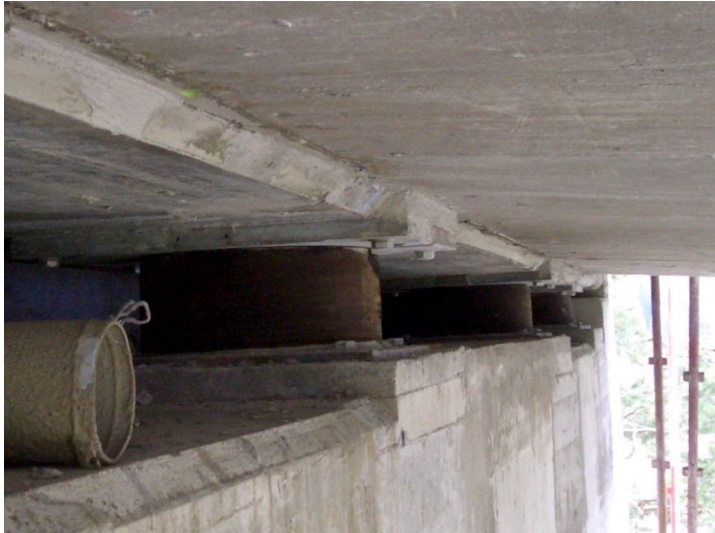
Abb. 10.3 Ertüchtigung mit hochdämpfenden Gummilagern beim Widerlager.
