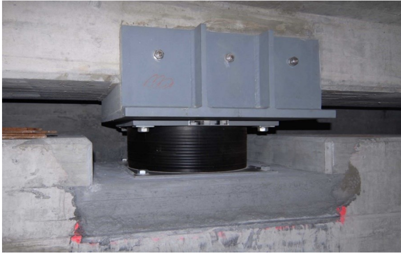
Abb. 10.11 Neues hochdämpfendes Gummilager als Ersatz für ein festes Topflager auf dem Widerlager Seite Bex.
