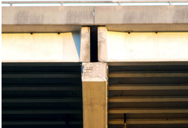
Abb. 4.1 Zwischenfugen über Stützen sind zu vermeiden.
