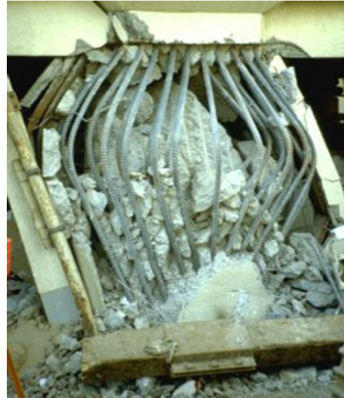
Abb. 3.4 Einsturz von Stahlbetonbrückenstützen beim Erdbeben in Kobe 1995. [30].
