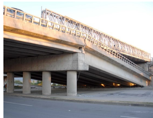
Abb. 3.1 Absturz eines Brückenträgers beim Erdbeben in Kobe 1995 (links) und in Chile 2010 (rechts) [30].
