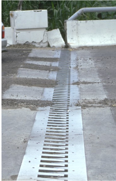
Abb. 3.11 Beschädigte Fahrbahnübergänge nach dem Erdbeben in Taiwan 1999 [30].
