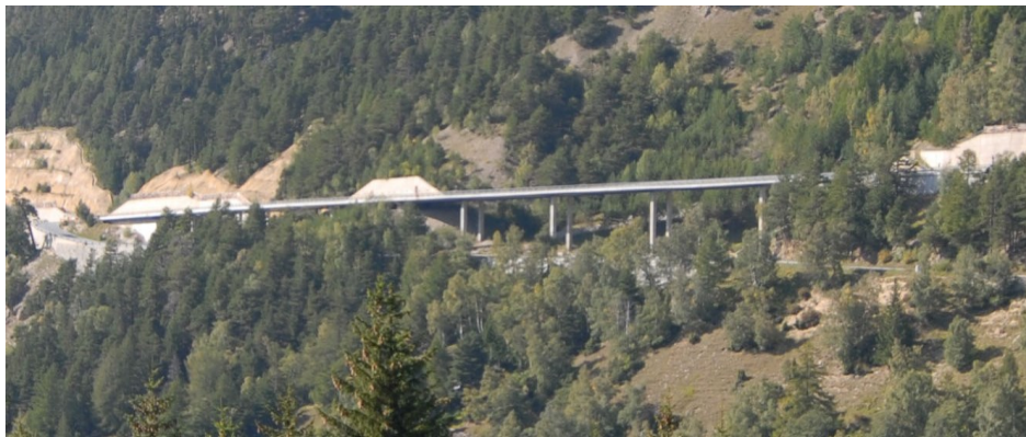
Abb. 10.1 Ansicht an die Brunnenbrücken.
