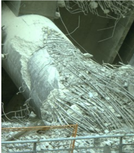
Abb. 3.4 Einsturz von Stahlbetonbrückenstützen beim Erdbeben in Kobe 1995. [30].
