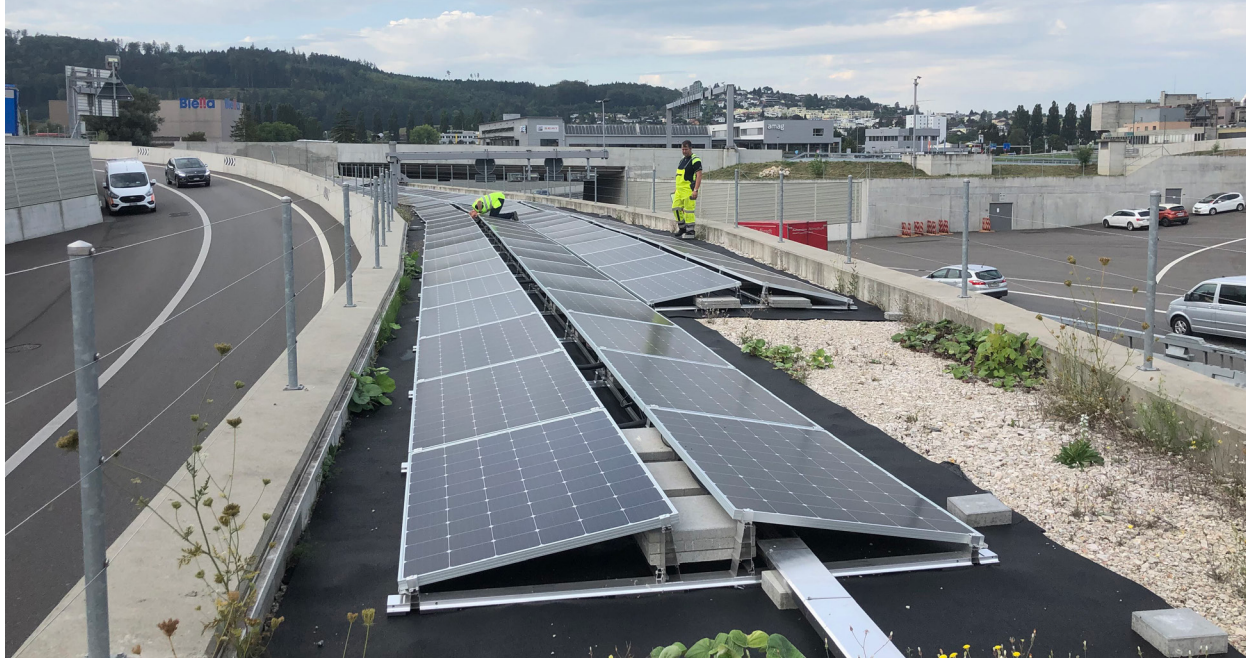
Südportal des Längholz-Tunnels (Biel)
