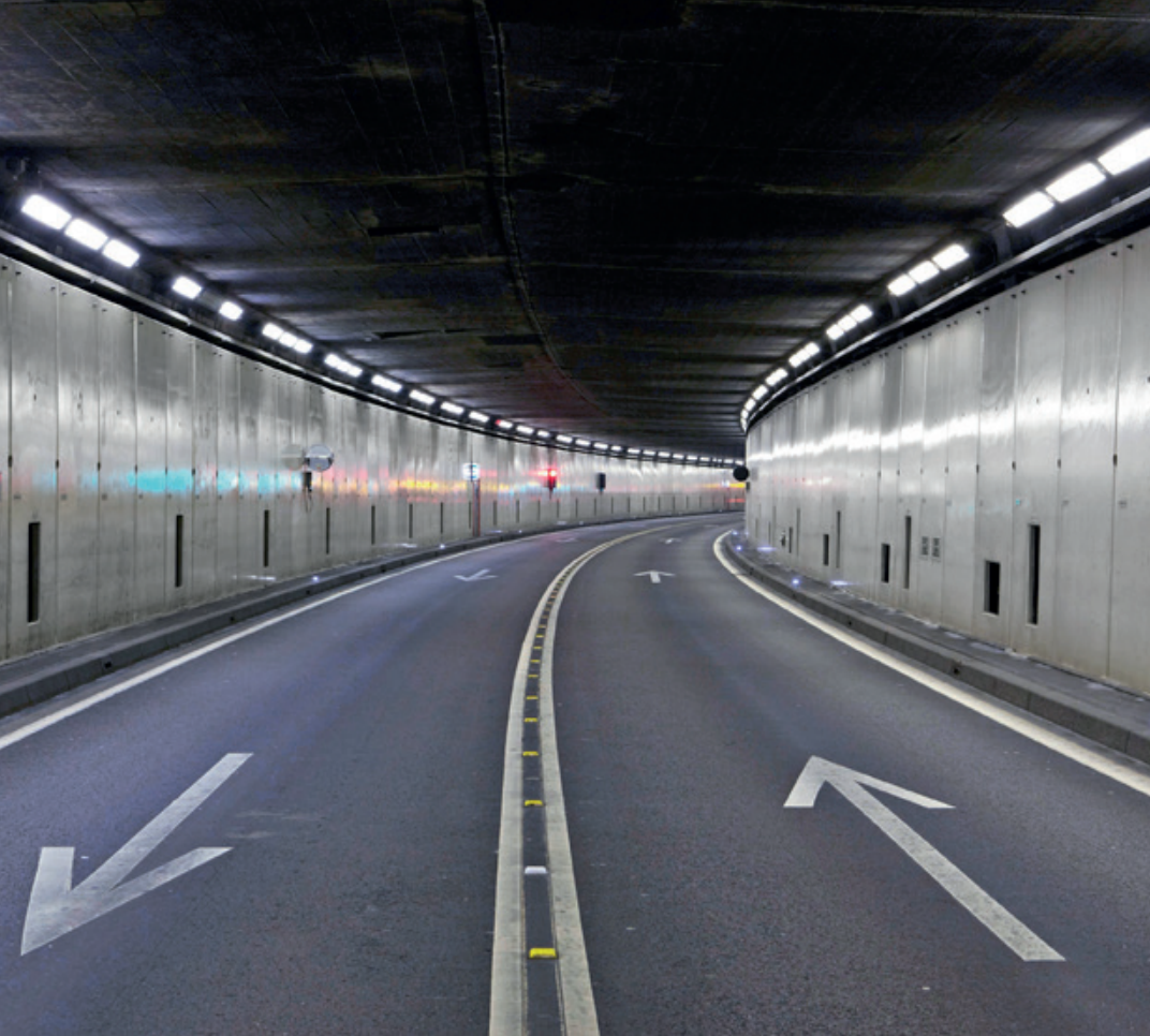
A2, Fahrtrichtungspfeile beim Südportal des Gotthard-Strassentunnels.
