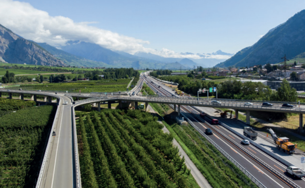
Der «Viaduc de Riddes» gehört dem Kanton Wallis und dem Bund gemeinsam. Das Bauwerk über der A9 wurde im Jahr 2021 verstärkt und ist nun wieder für sämtlichen Verkehr geöffnet.
