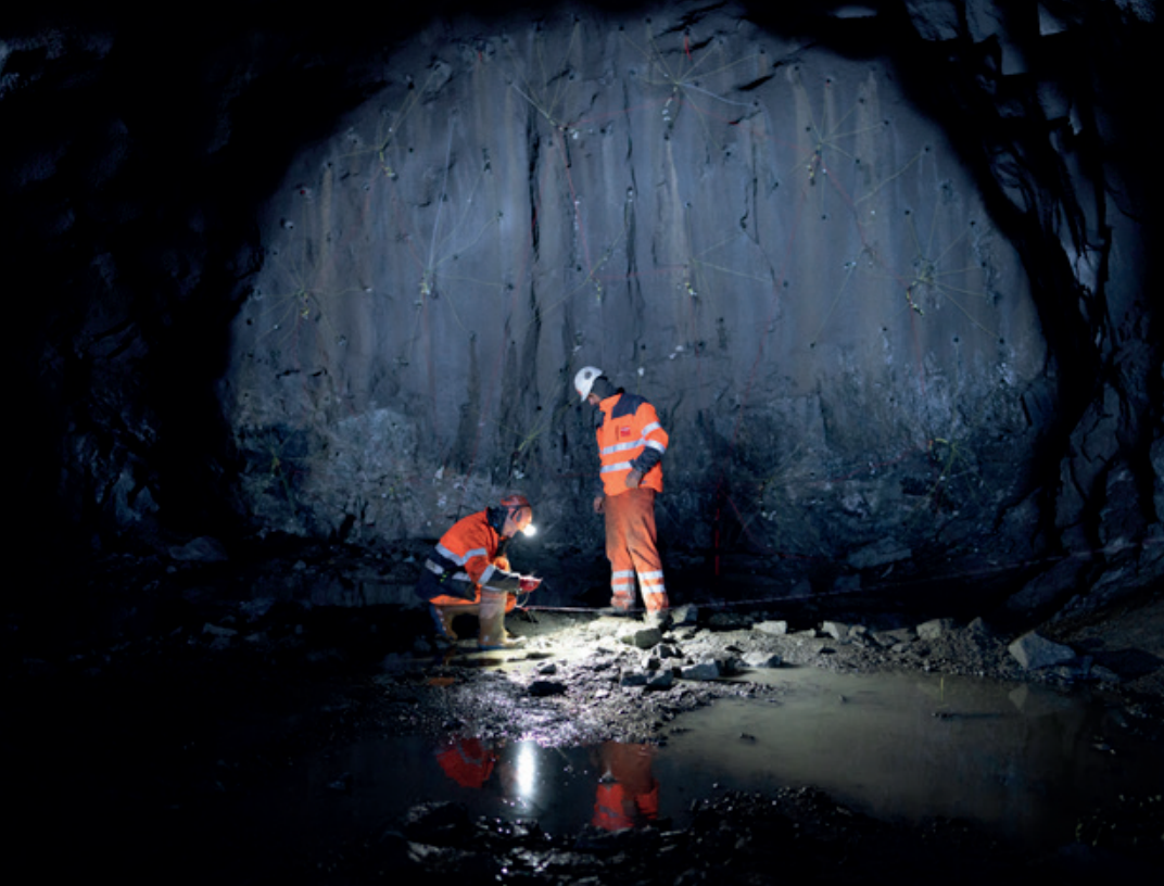
Mineure und der Sprengmeister bereiten in Göschenen die Sprengladungen vor, um den Zugangsstollen für die zweite Röhre des Gotthard-Strassentunnels zu bauen.
