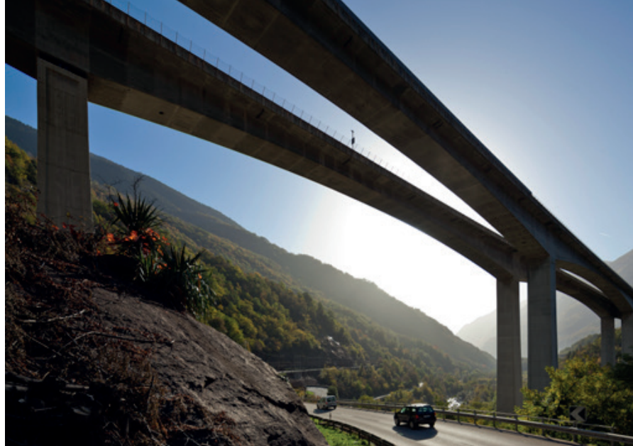
Der Biaschina-Viadukt der A2 in der Leventina, Blick Richtung Süden.
