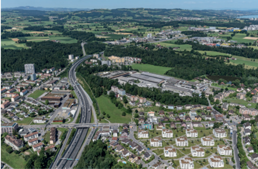
Blick auf die A2 und die nationale Verkehrsmanagementzentrale des ASTRA bei der Ausfahrt Emmen Nord.
