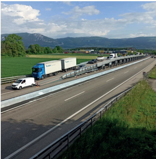
Innovativer Ansatz in der Unterhaltstechnik: die ASTRA Bridge im Piloteinsatz bei Belagsersatzarbeiten auf dem A1-Abschnitt Rechterswil–Luterbach.
