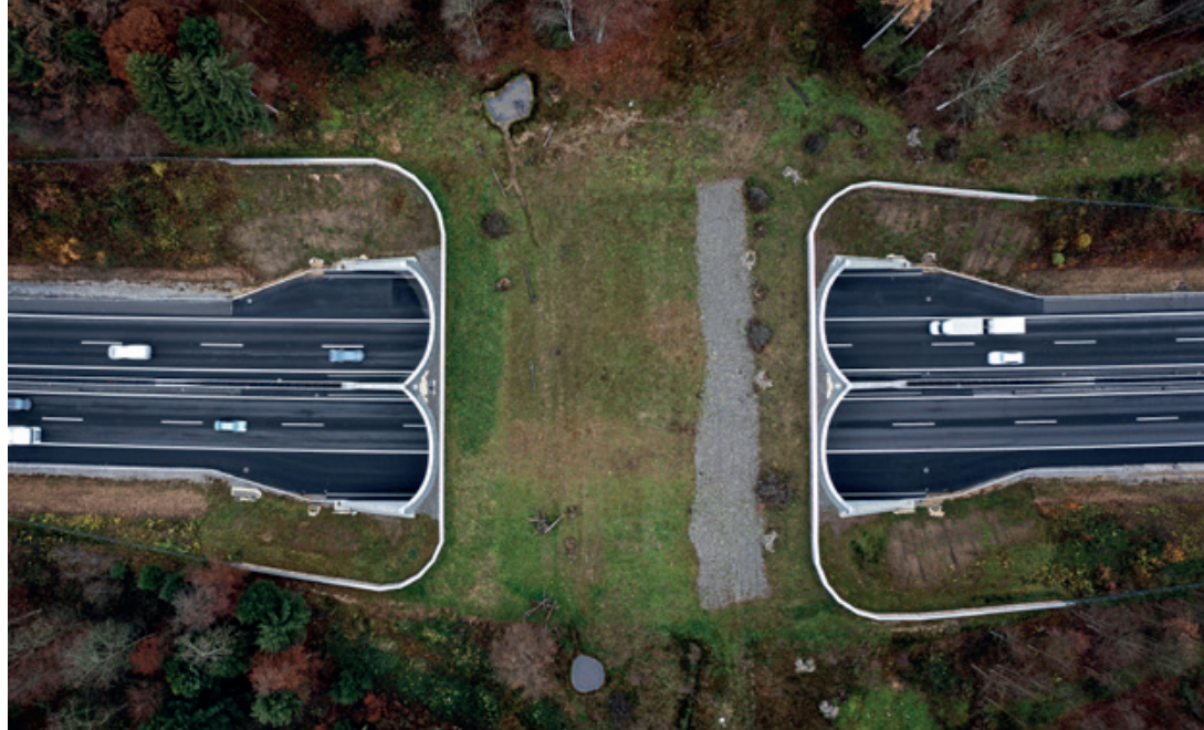
Wildtierüberführung aus Holz über die A1 zwischen Suhr und Gränichen.
