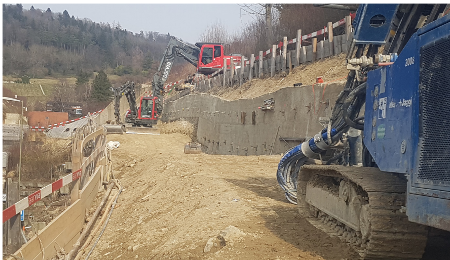
Bagger tragen kieshaltige Bodenschichten für den neuen Radweg ab.
