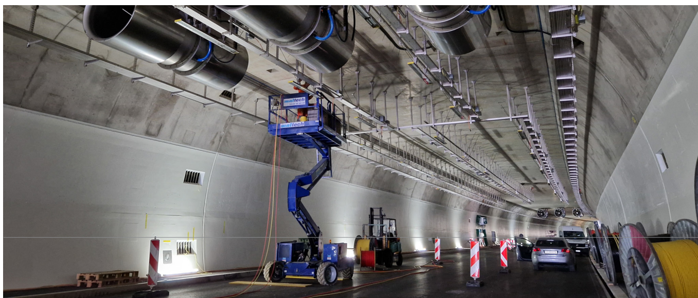
Mit einer Hebebühne montieren Spezialisten die Ventilatoren für die Tunnellüftung.
