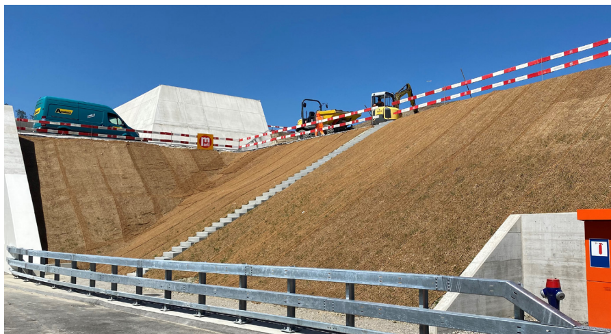
Der Seitenhang beim Portal der 3. Röhre Gubristtunnel in Affoltern wird begrünt.
