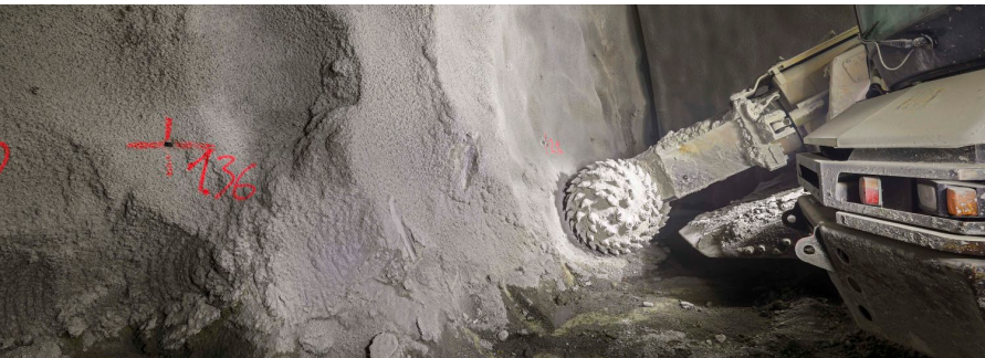
Auf der Affoltemer Seite raspelte sich die Teilschnittmaschine durch den Berg.
