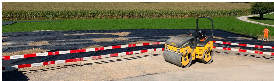
Der Installationsplatz Bifängli in Weiningen ist eingerichtet.
