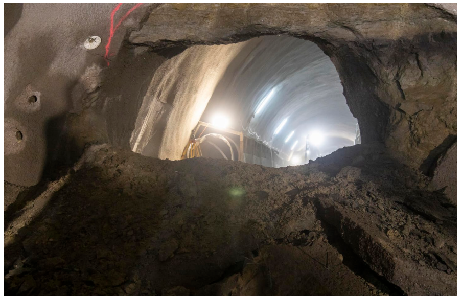
Der Durchschlag der 3. Röhre Gubristtunnel ist am 22. September 2020 erfolgt.
