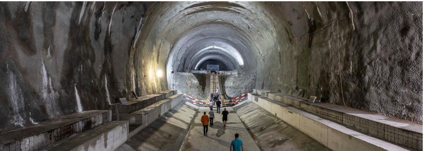
Die am Bau Beteiligten haben auf der Seite Weiningen gespannt auf den Durchschlag der 3. Röhre Gubristtunnel gewartet.
