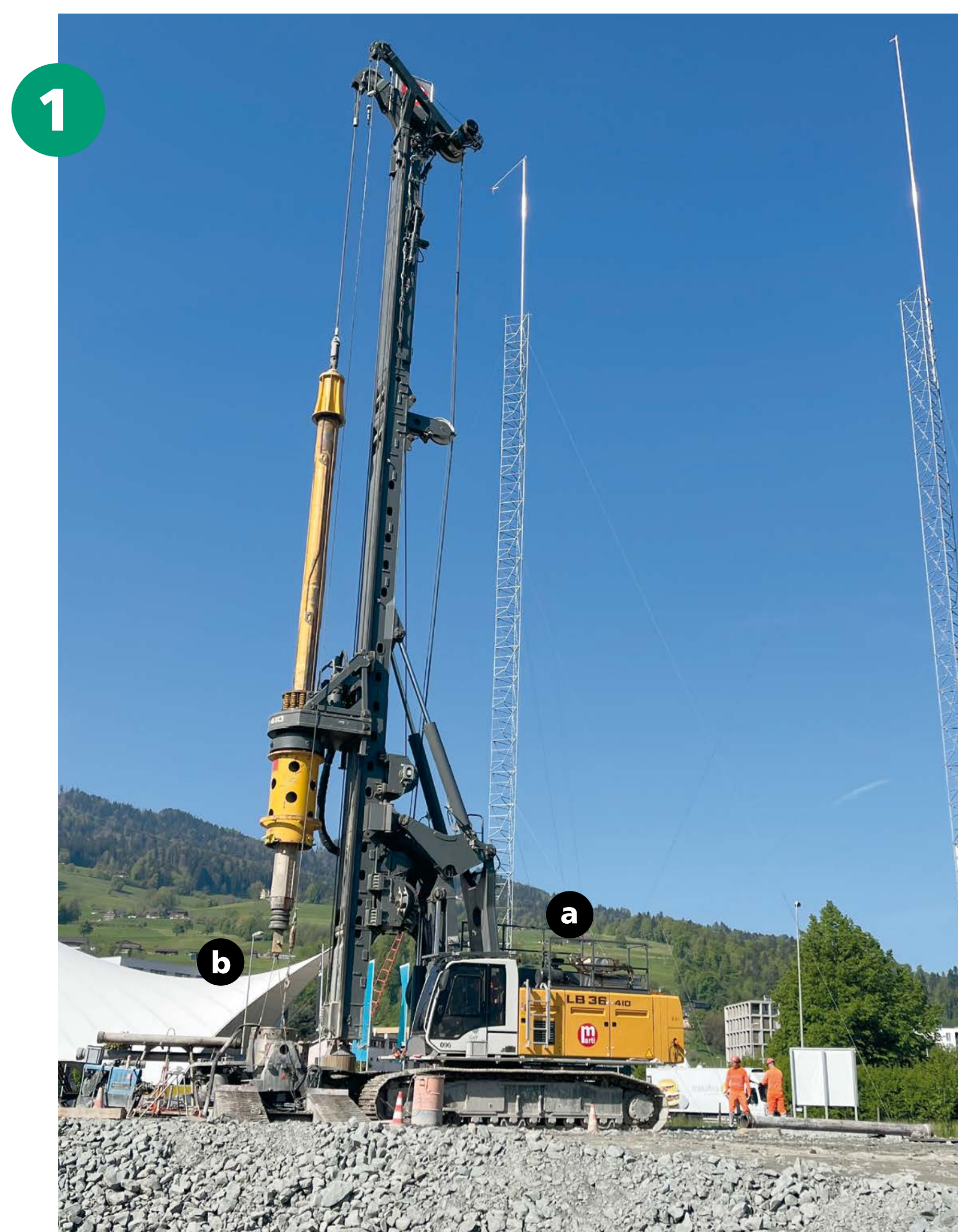
Vorbereitung zum Pfahlversuch: Das rund 100 Tonnen schwere Drehbohrgerät (a) bohrt ein Stahlrohr (b) in die Tiefe (Archivbild).
