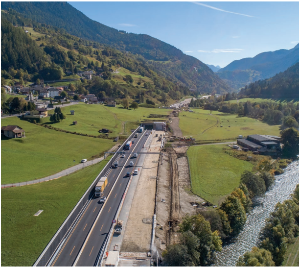
Comparto Quinto tratto con lavori in corso
