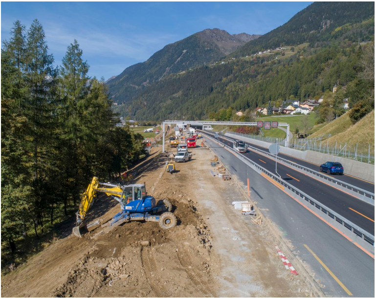
Lavori in corso comparto Quinto
