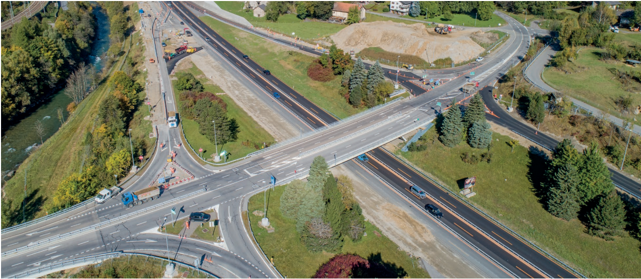
Uscita autostrada Quinto con lavori in corso
