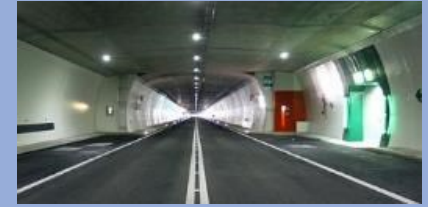
Tunnel und Geotechnik
