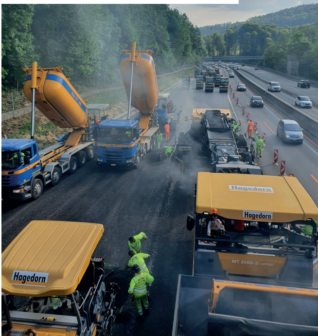
Maschinentross für die Belagsarbeiten.
