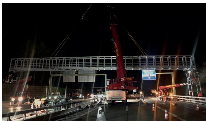
In einem Zeitfenster von maximal 15 Minuten wird das Signalportal eingeschwenkt.
