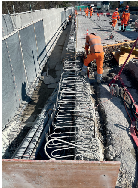
Bei der Überführung Winterthurerstrasse werden die Brückenränder erneuert.
