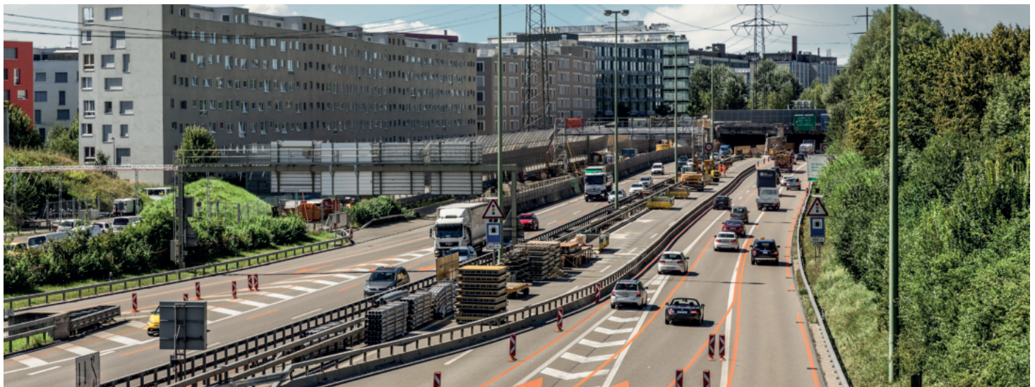
Die Nacharbeiten in der Vorzone des Stelzentunnels in Fahrtrichtung Bern dauern bis voraussichtlich Anfang August 2018.
