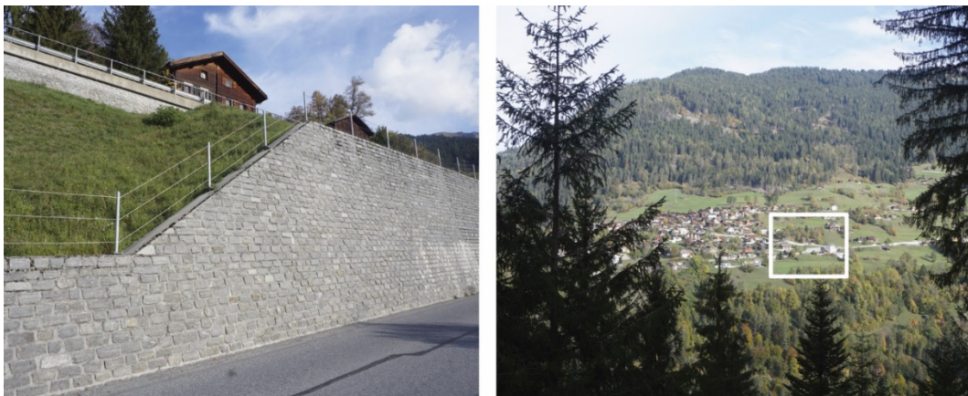
Abb. 40 Stützbauwerk am Siedlungsrand
