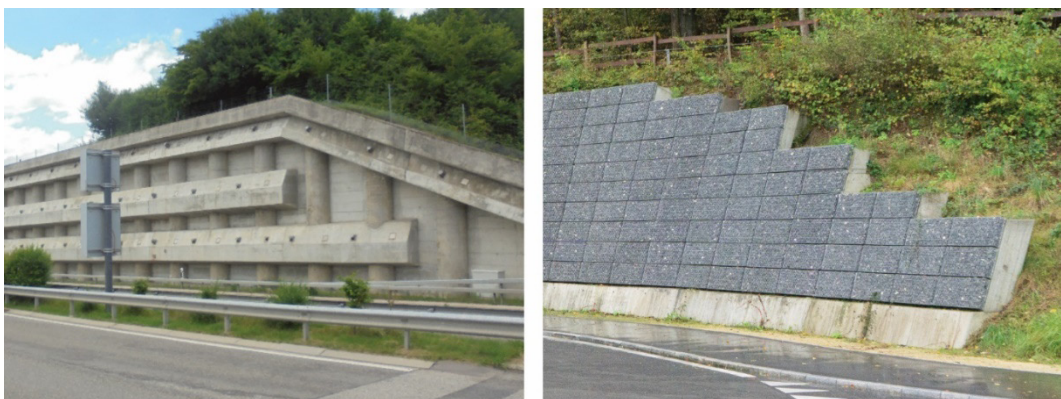
Abb. 8 Sichtbarkeit und Verkleidung des eigentlichen Bauwerks
