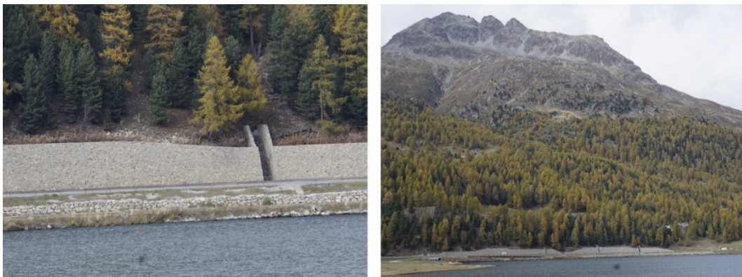
Abb. 44 Der Landschaft entsprechende Farbe einer Natursteinmauer
