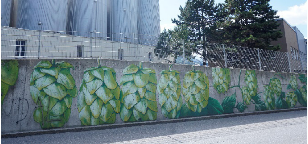
Abb. 5 Betonmauern als Plattform künstlerischer Entfaltung
