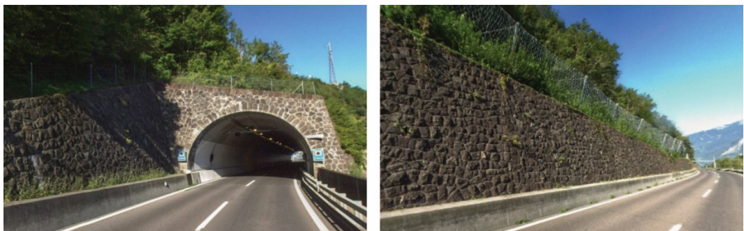
Abb. 52 Einheitliche Gestaltung der Kunstbauten an der N3
