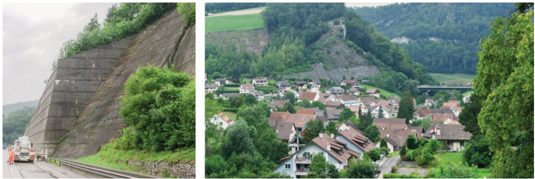
Abb. 41 Schlechte Einsehbarkeit trotz stattlicher Bauwerkshöhe
