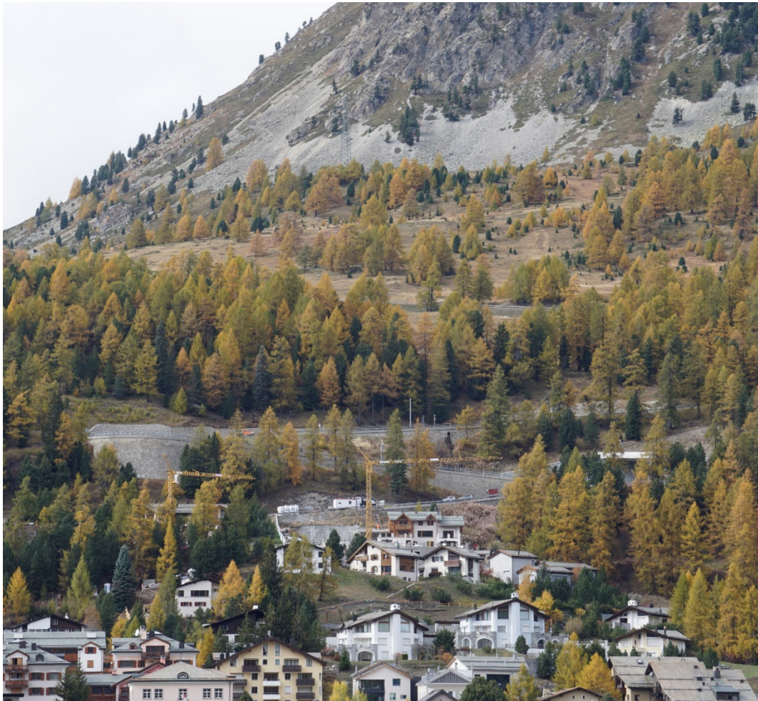
Abb. 57 Kennzeichnung des Strassenverlaufs durch die Stützbauwerke
