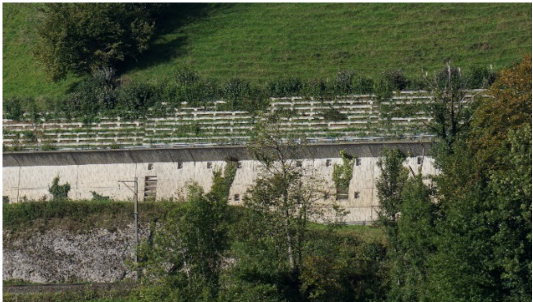
Abb. 46 Raumgitterwand und Betonmauer - T16 bei Wattwil
