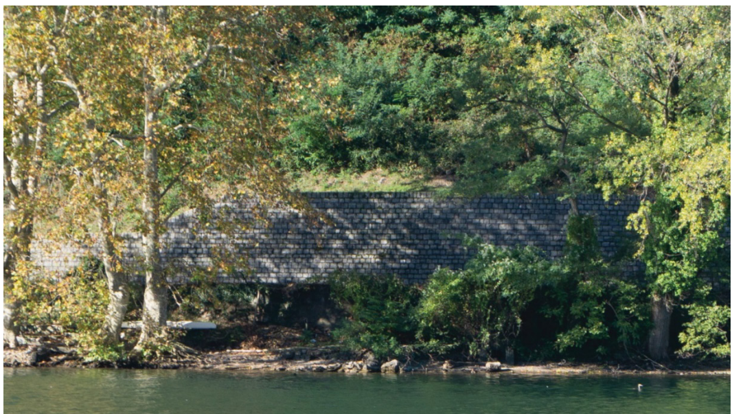
Abb. 49 Natursteinmauer im Schatten vorgelagerter Bäume
