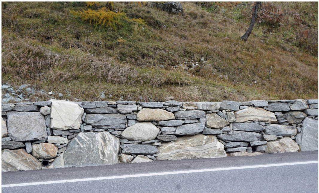
Abb. 17 Trockensteinmauer im Strassenraum
