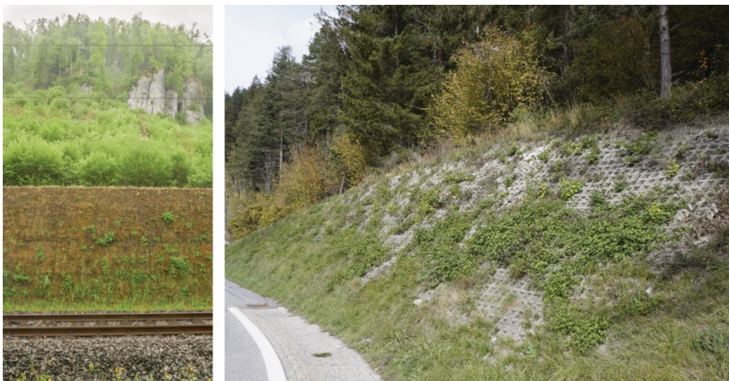
Abb. 19 Bedingt naturnahe Gestalt erdbewehrter Stützsysteme
