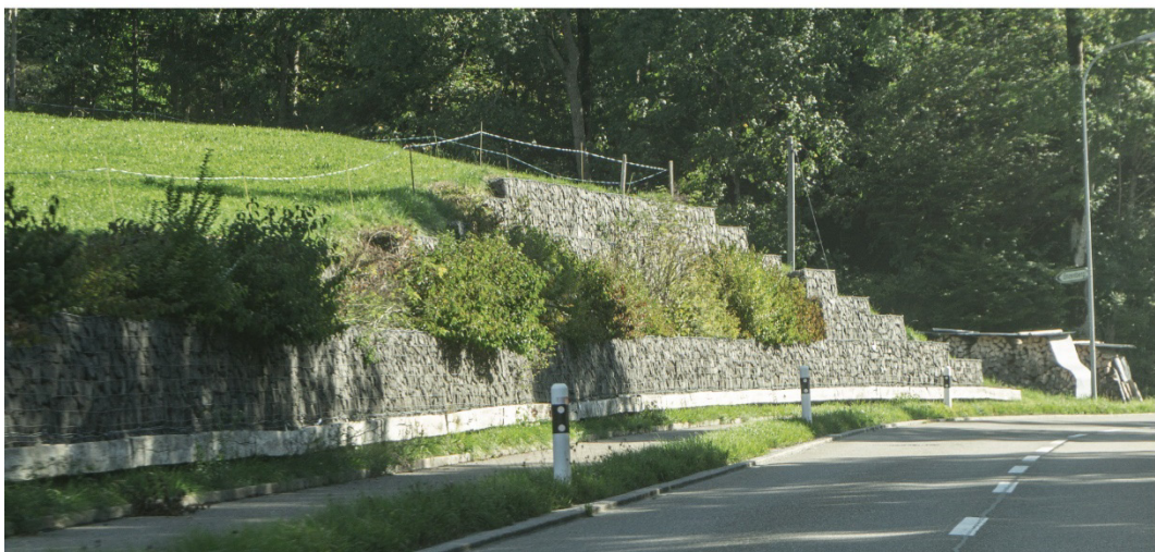
Abb. 15 Bauwerkskonturen mit Gabionen
