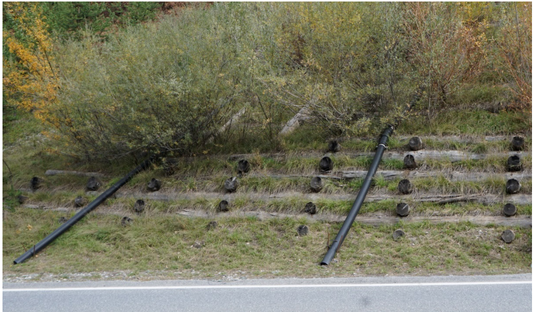
Abb. 20 Hangsicherung mit Holzverbau und Weidebepflanzung
