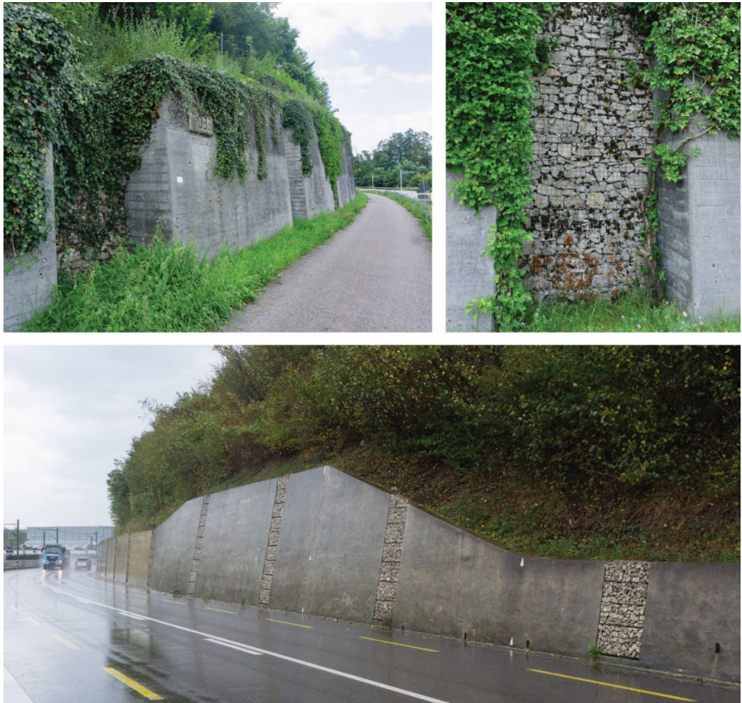
Abb. 23 Mit Steinkörben gegliederte Betonstützmauern
