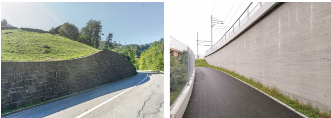
Abb. 29 Akzentuierung der Mauerkrone
