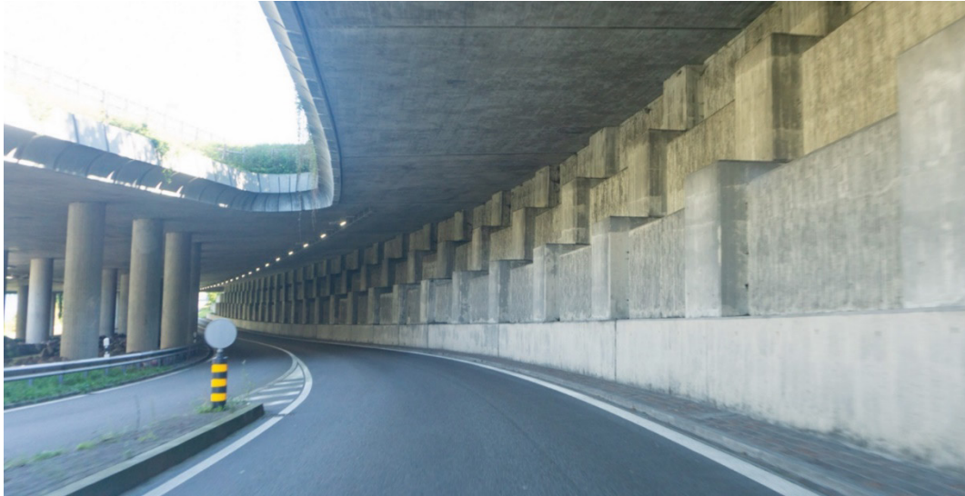
Abb. 7 Explizite Formensprache eines Betonbauwerks
