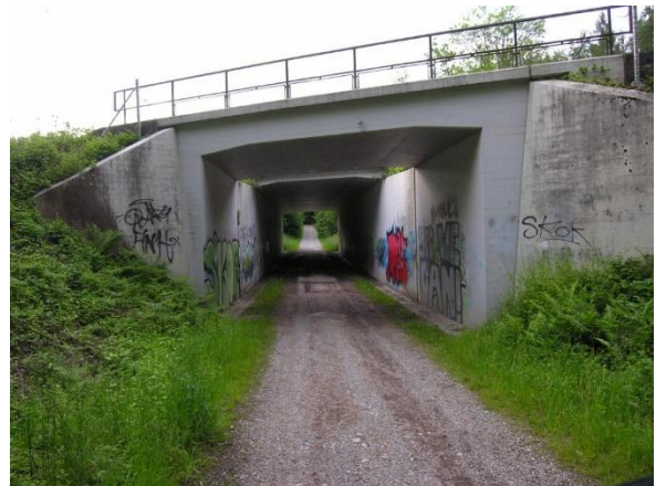
Bild M- 10. Blick von Süd nach Nord.
