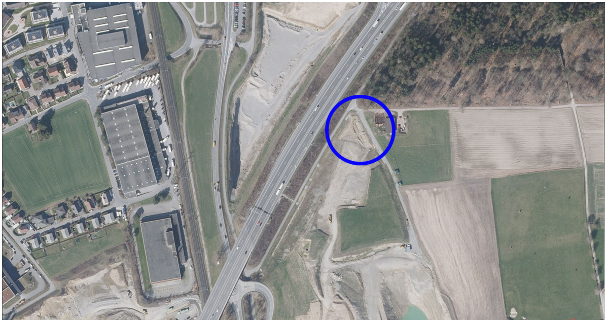
Abb. 5.1 Standort der Pioniergewässer in der Kiesgrube Mägenwil (hier noch im Bau).
